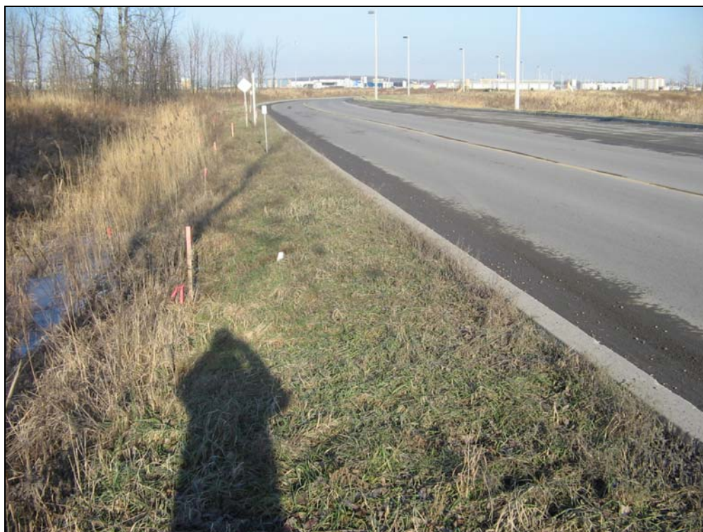
Photo 3 – Rue Félix-Leclerc à proximité du croisement de la voie ferrée – Vue vers l’est
