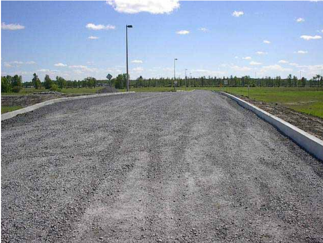
Félix-Leclerc extension (Vaud-12) point F, direction Sud-Ouest (F-SO)
