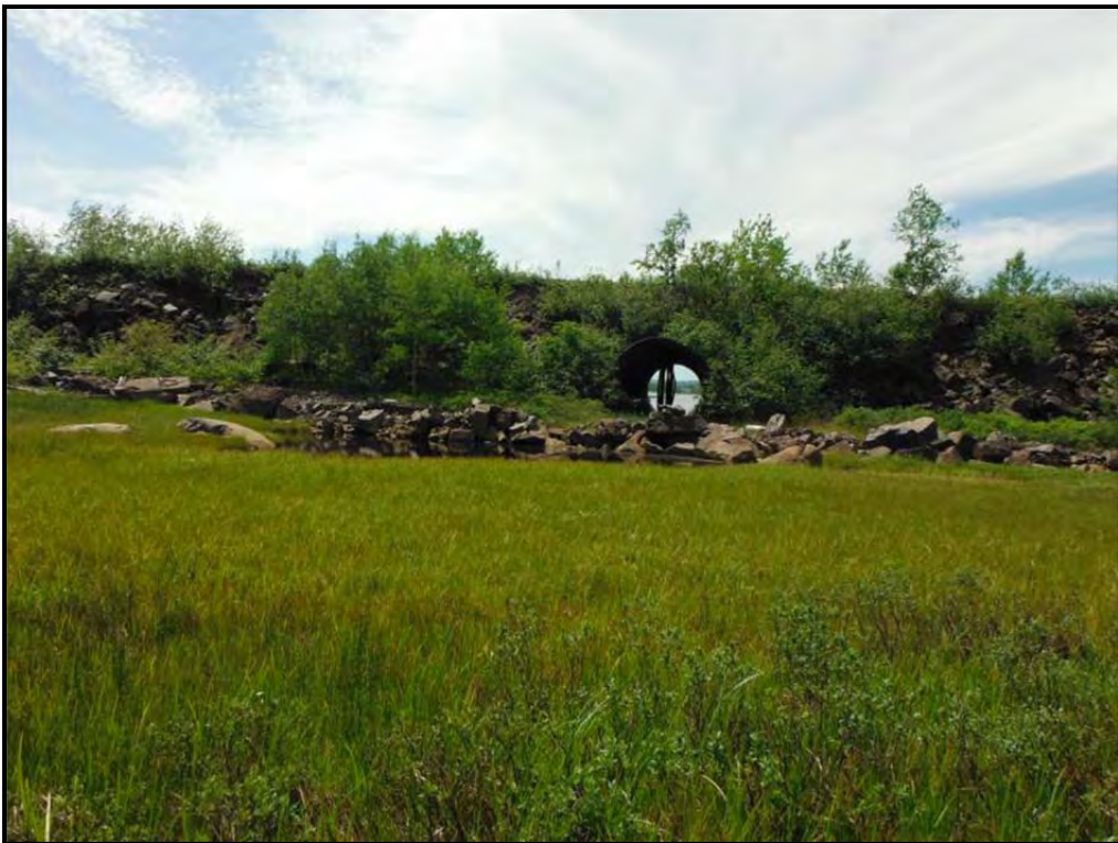
Photos 4 (14-06-25): Ponceau et lien hydrologique entre le complexe de milieux humides et la Baie Brunelle.
