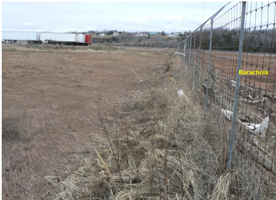
Limite à l'est de la propriété, vue vers le nord.
