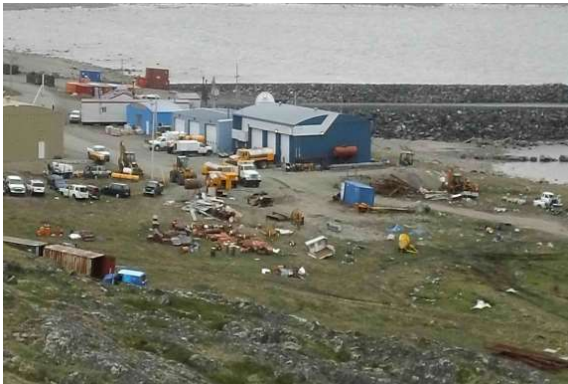
Figure 8 : Vue du lieu où des matières résiduelles étaient entreposées à côté du garage municipal, une fois les matières retirées, août 2013.
