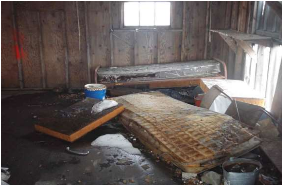
Figure 28 : Matières résiduelles trouvées à l'intérieur des bâtiments du site WB-9, juin 2012.
