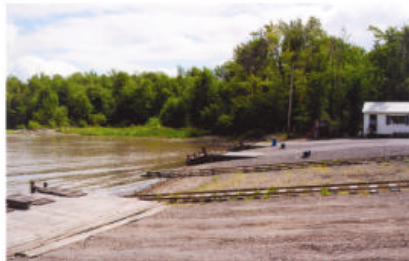
Rail de halage et rampes d'embarquement / marine railway access ramps
