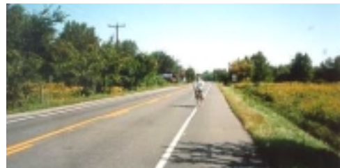
Photo 6-3 – Accotement asphalté d'un seul côté de la route : circulation à contresens
