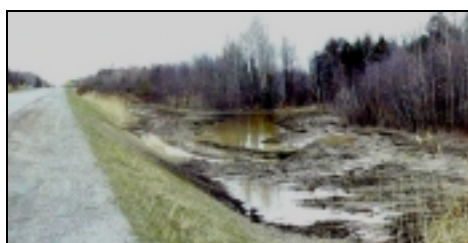
Photo 6-7 – Des dommages importants causés à l'emprise par la circulation des VHR
