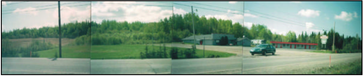
Photo 1 : A partir de l'entrée du lot 21, au chaînage 4+630d, vue d'ensemble des bâtiments du hôtel Chevalier et l'entrée à ce commerce, entre les ch 4+640 et 4+660g.
