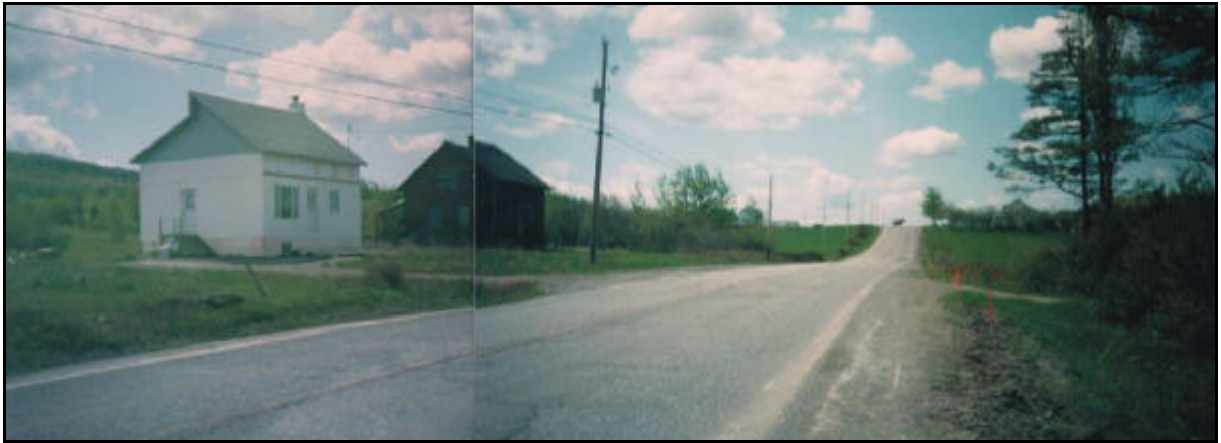
Photo 10 : Du ch. 4+000, vue en direction sud-ouest, nouvelle résidence no. civique 180 (au ch. 4+030g) construite à proximité d'une maison abandonnée.
