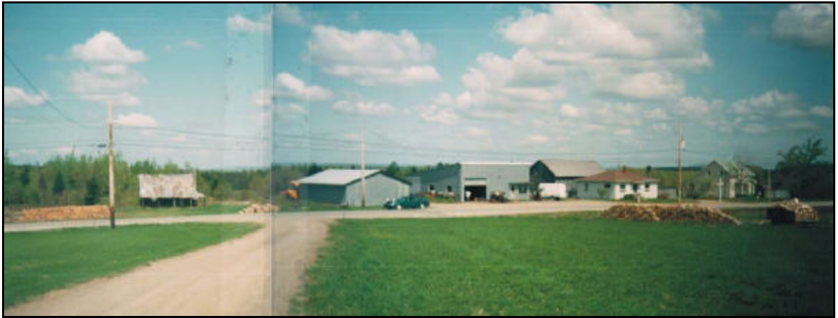
Photo 2 : A partir de l'entrée privée de la résidence no. Civique 240, vue des bâtiments situés du côté N.O. de la route, entre les ch. 4+200 à 4+400. 2 résidences, 2 garages et une maison abandonnée.
