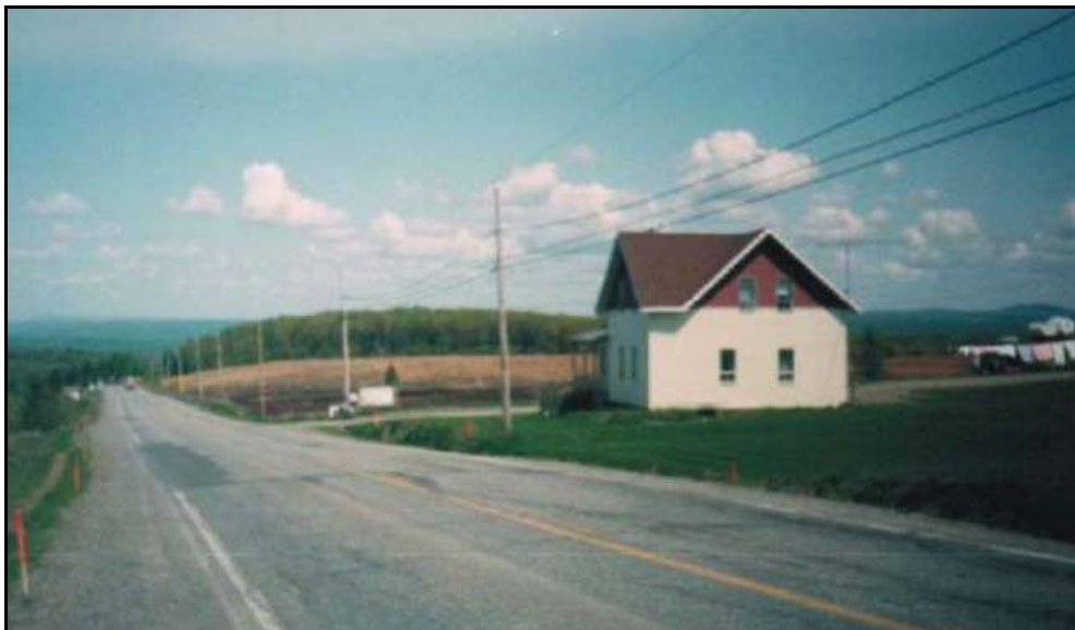
Photo 12 : Résidence no. civique 130 qui se retrouvera dans l'emprise du projet.
