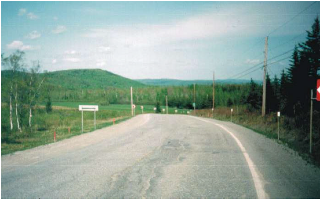
Photo 8 : À partir du centre de la chaussée au ch. 3+040, aperçu de la deuxième courbe signalée par des chevrons. Perte de visibilité et profil accidenté.
