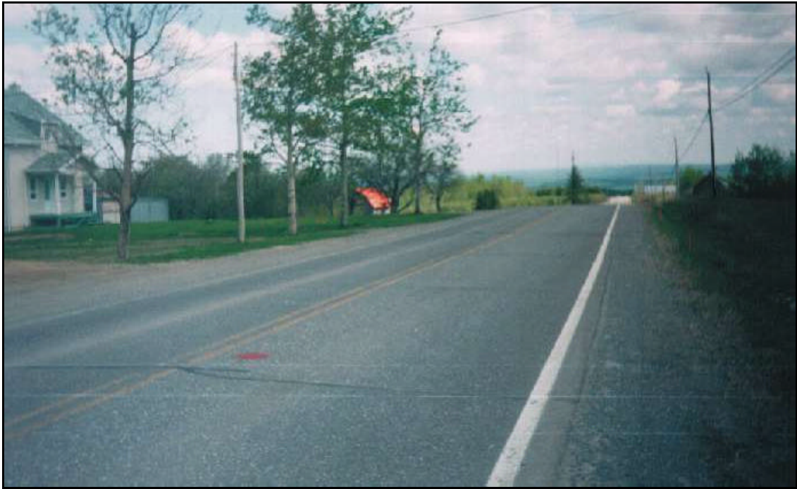
Photo 6 : Profil actuel de la route et perte de visibilité dans le secteur du cd. 4+200
