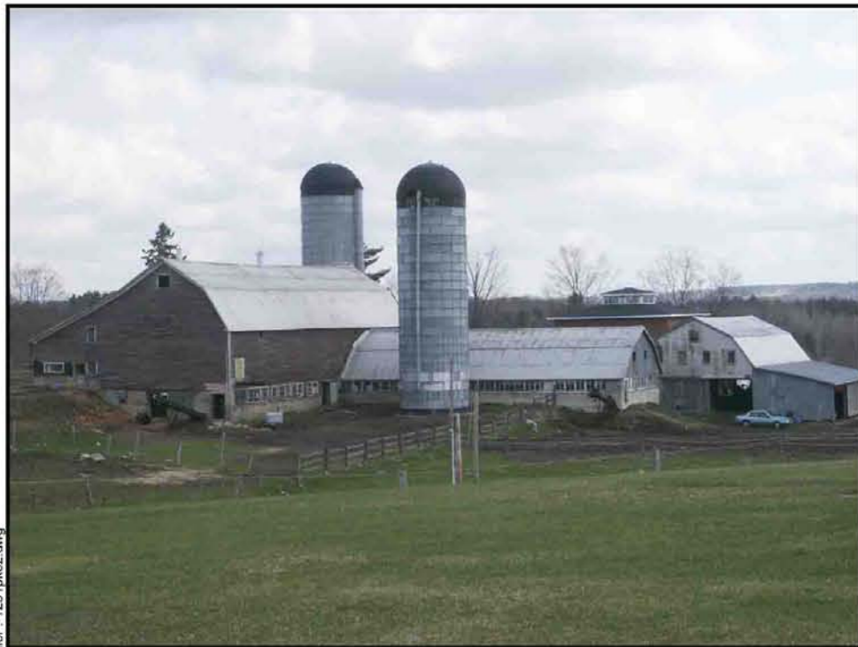
4- Vue sur l'étable et autres bâtiments
