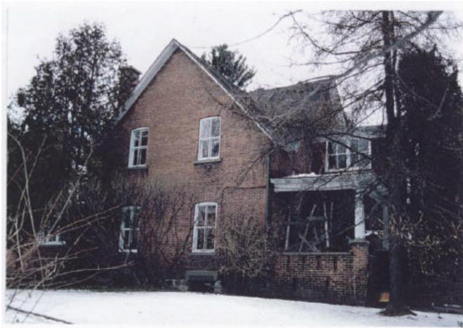
Photo 8 : Bâtiment situé au 15 de la rue Queen dans l'arrondissement de Lennoxville, ayant une valeur patrimoniale supérieure
