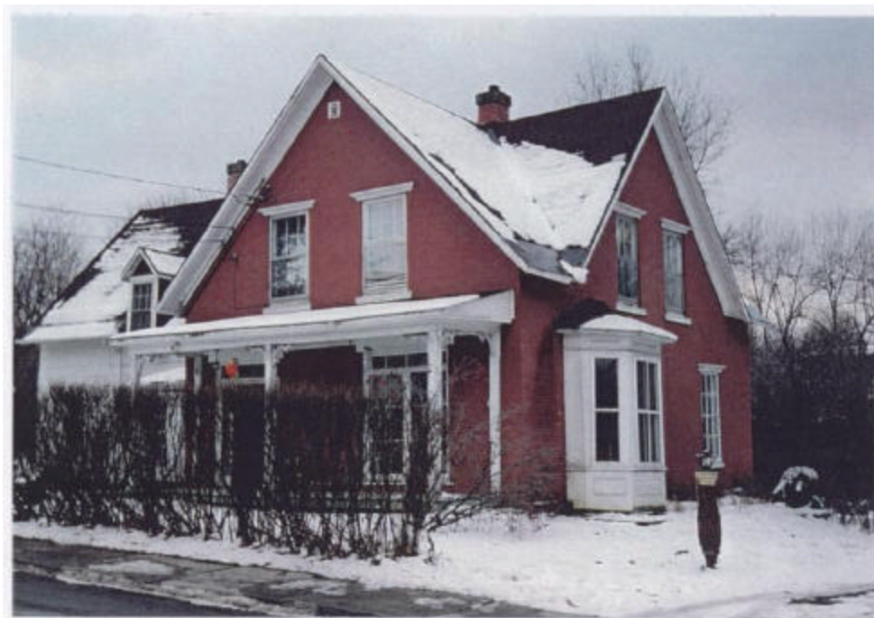
Photo 10 : Bâtiment situé au 12 et 14 de la rue Massawippi, dans l'arrondissement de Lennoxville, ayant une valeur patrimoniale supérieure
