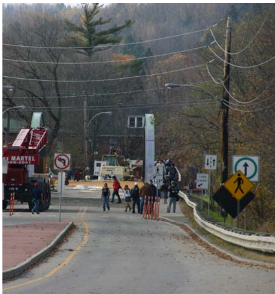
Photo N° 1 : Réaménagement du pont enjambant la rivière Massawippi
