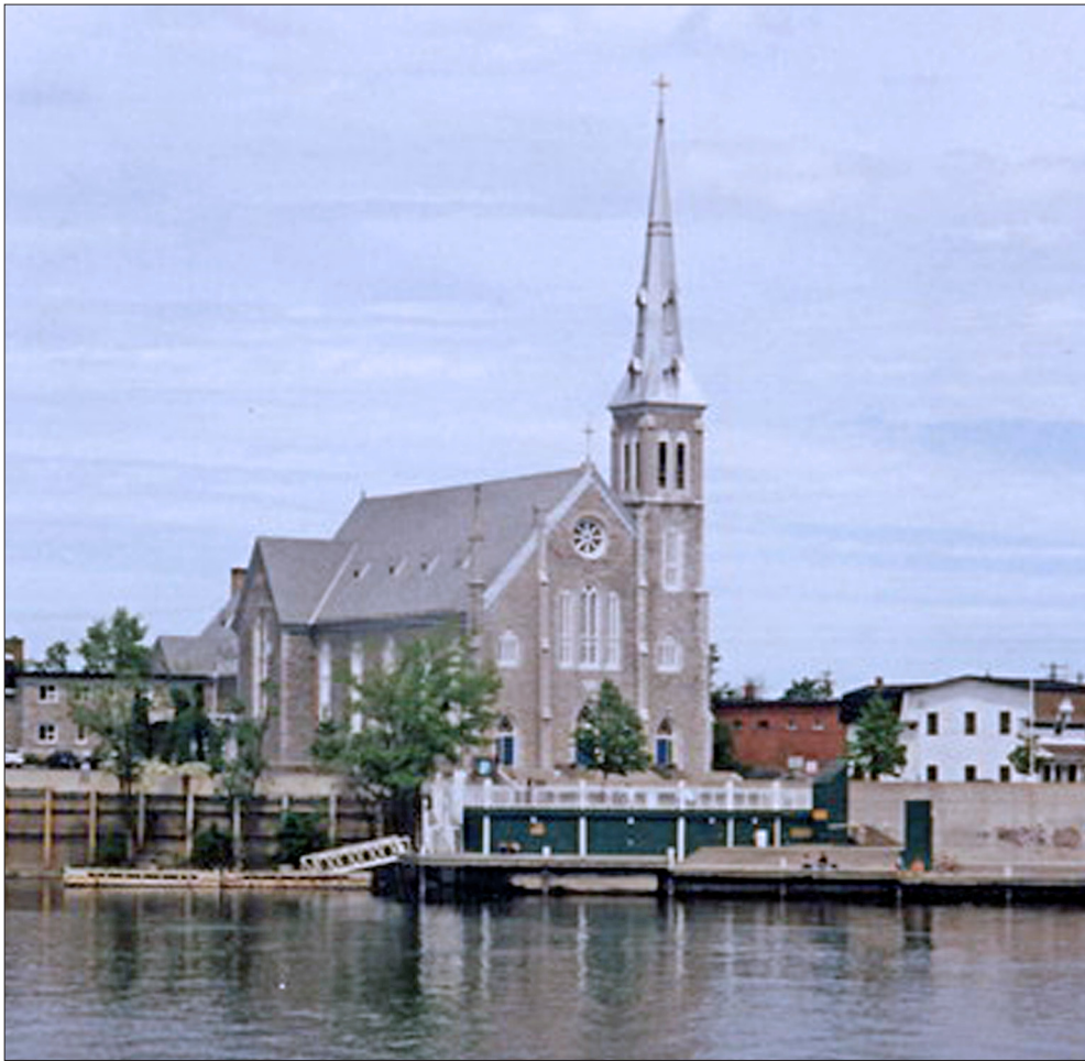
Figure 5.5 Église Saint-François de Sales, Pointe-Gatineau, construite en 1840.
