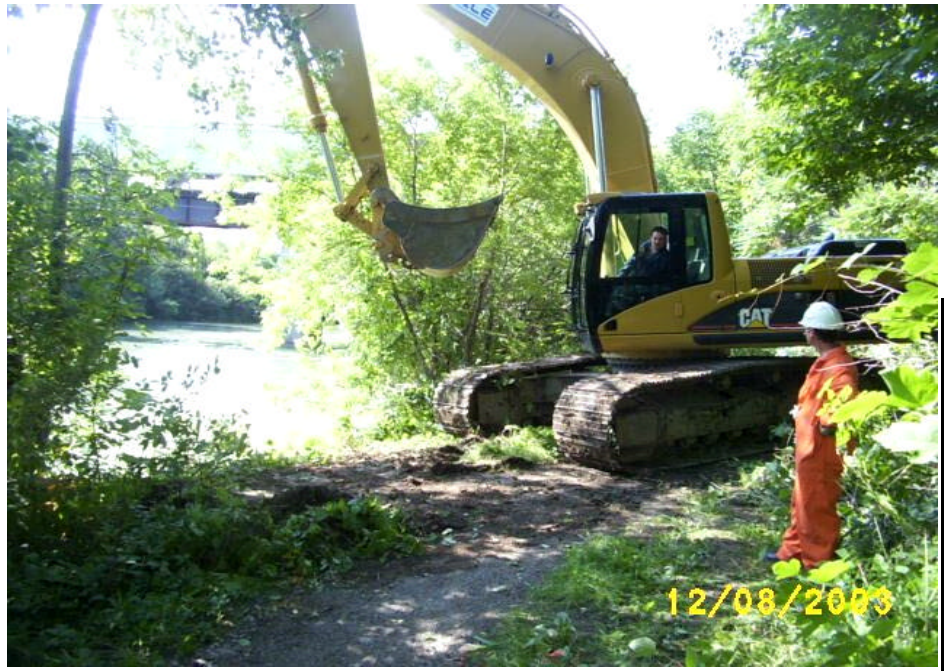
Photo n° 3. Site des travaux et excavatrice utilisée
