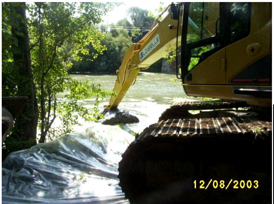
Photo n° 4. Début des travaux, Godet # 1 (note : membrane de polythène pour la protection du site)
