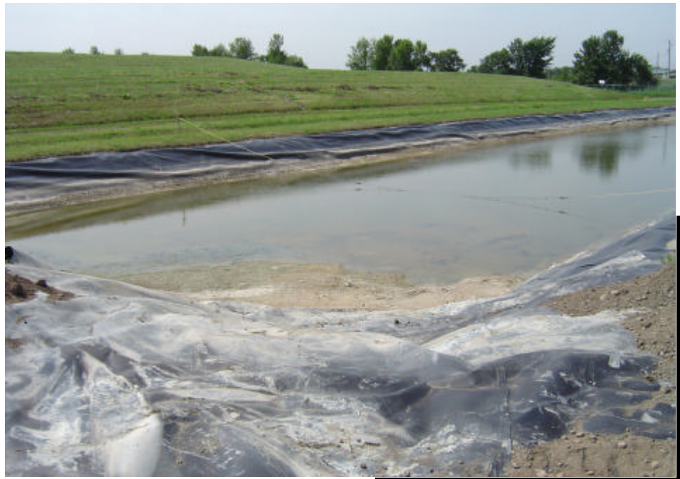
Photo n° 17. Bassin de traitement # 6 avant le déversement de la benne # 1
