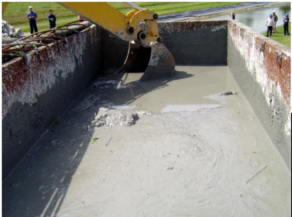
Photo n° 16. Benne # 1, prélèvement des échantillons. Noter la consistance des sédiments suivant leur transport au site d'enfouissement
