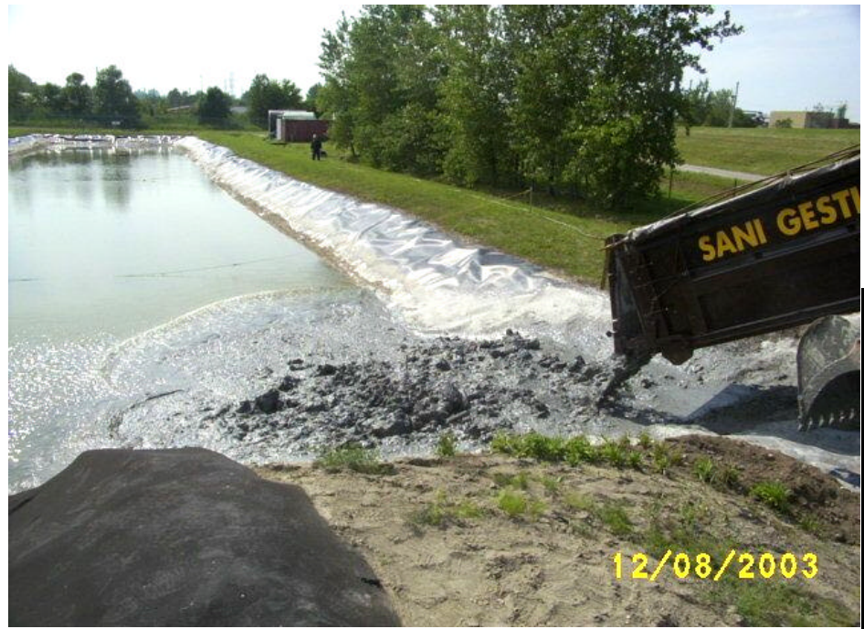
Photo n° 31. Déversement de la benne #2, matériau fluide
