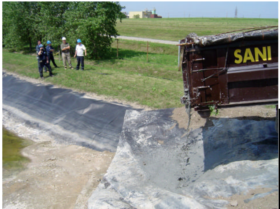
Photo n° 18. Comportement liquide des sédiments avant le déversement de la benne #1
