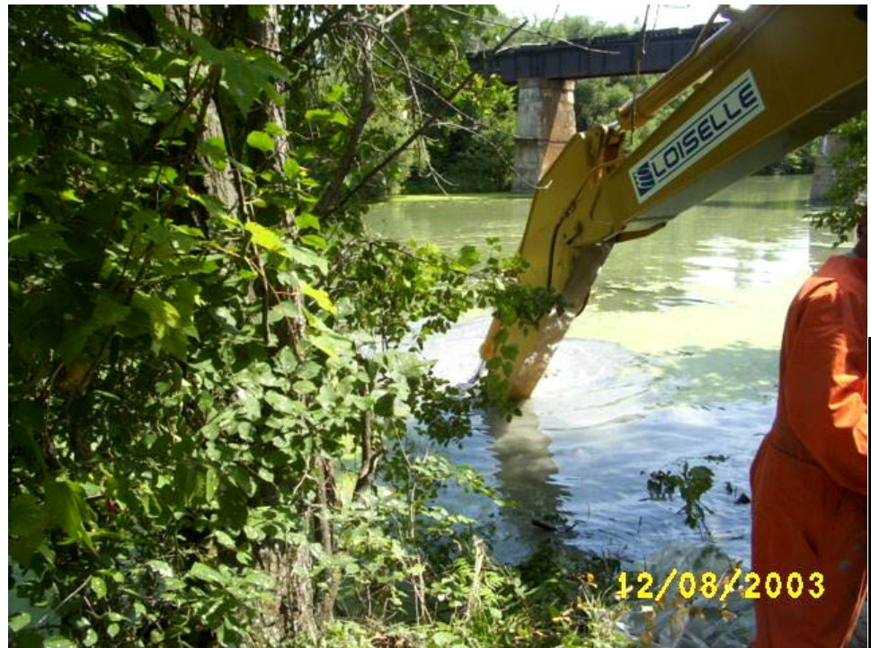
Photo n° 24. Suite des travaux, environ 3,2 m de profondeur (Godet # 8, benne # 2)
