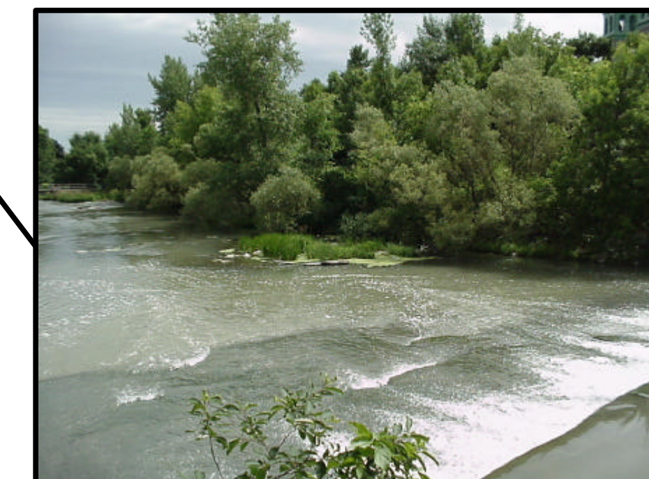
Pied de la digue Howard-Smith montrant l'affleurement du roc
