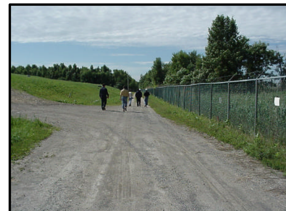
Chemin longeant le côté ouest des cellules d'enfouissement de PPG
