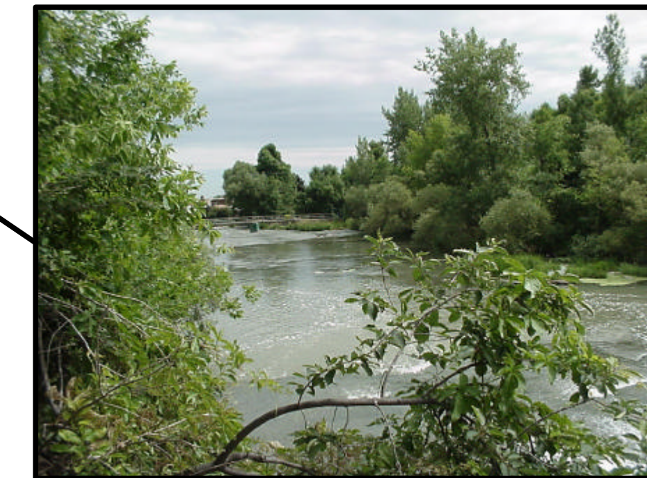
Pont piétonnier situé à environ 112 m en aval de la digue Howard-Smith (accès au bois Robert à partir de Beauharnois)
