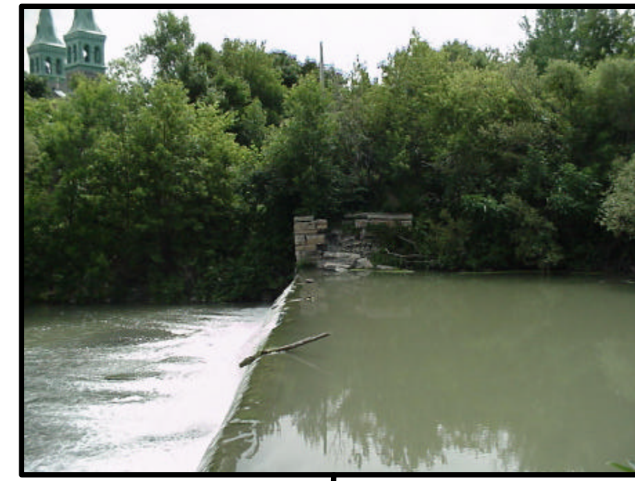
Vue vers l'est de la digue Howard-Smith
