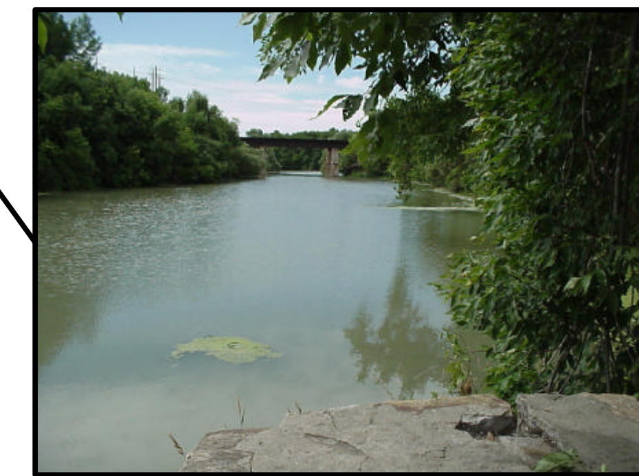
Vue du pont de chemin de fer situé à environ 175 m en amont de la digue Howard-Smith
