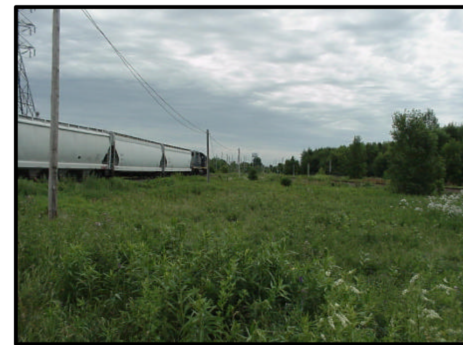
Vue vers l'est du chemin de fer longeant les terrains de PPG
