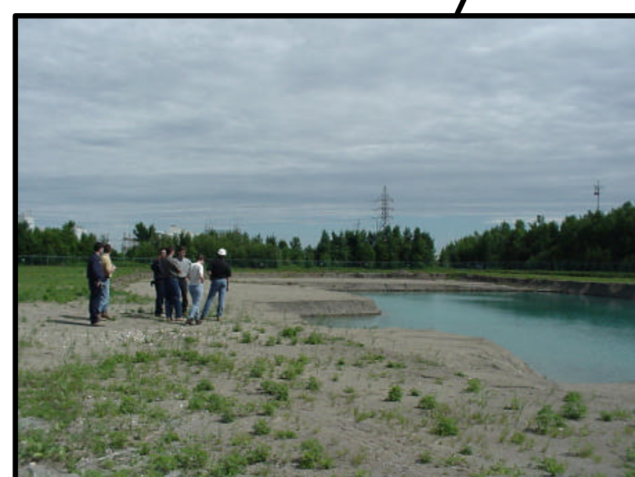
Côté ouest du banc d'emprunt d'argile (future cellule no. 12)
