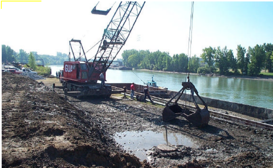
Photo 7 La barge est vidée de son contenu de sédiments
