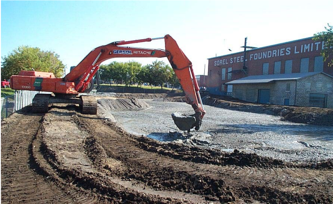
Photo 8 Bassin d'assèchement (celui près du pont Turcotte en 2002)
