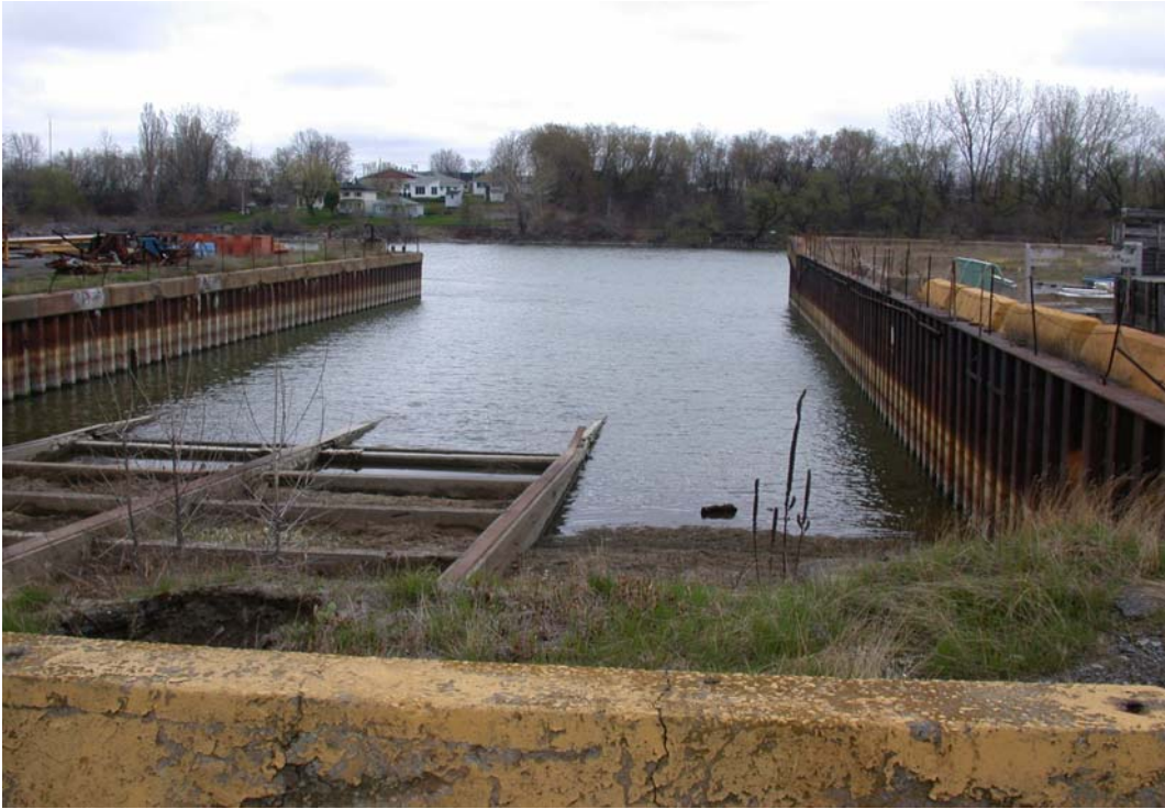
Photo 10 Rampe de mise à l'eau
