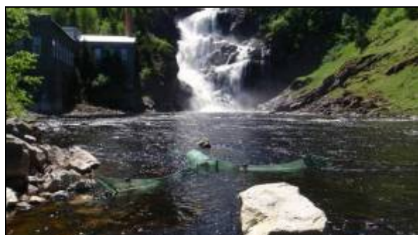
Photo B. Verveux installé en rive droite dans le bief aval.
