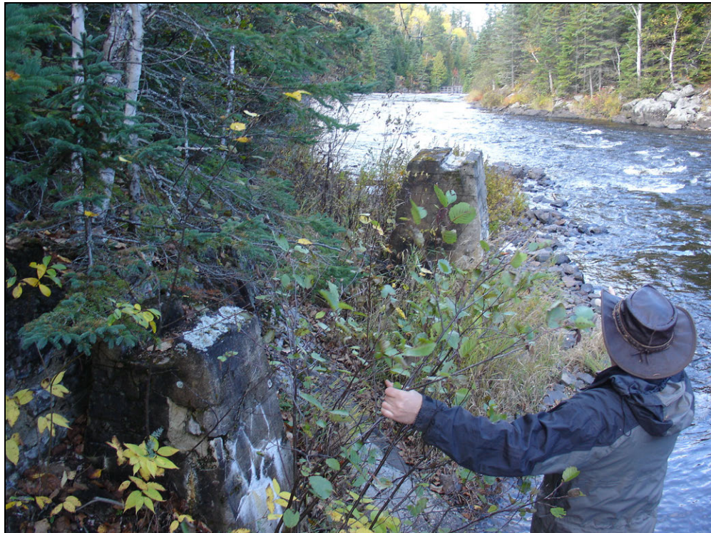
Photo 6 : vestiges (piliers de la scierie) associés au moulin de la chute Maligne.
