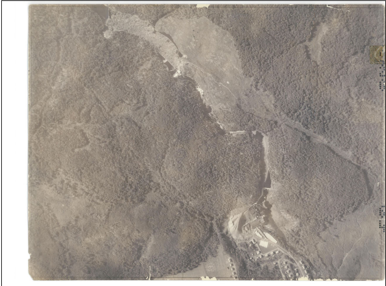
Figure 13 : rivière Ouatouchouan entre Val Jalbert au nord (bas de la photo) et le moulin de la chute Maligne (haut de la photo) (Programme de stabilisation des berges, Rio-Tinto Alcan).
