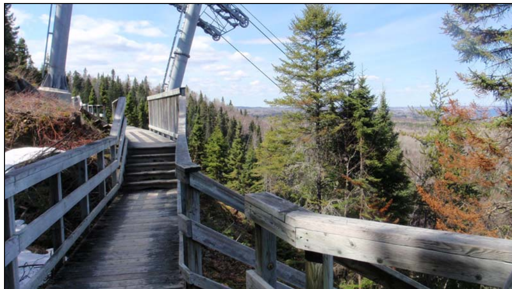
Photo 7.46 : Sentier pédestre et escaliers aménagés sous le téléphérique en rive droite de la rivière Quiatchouan
