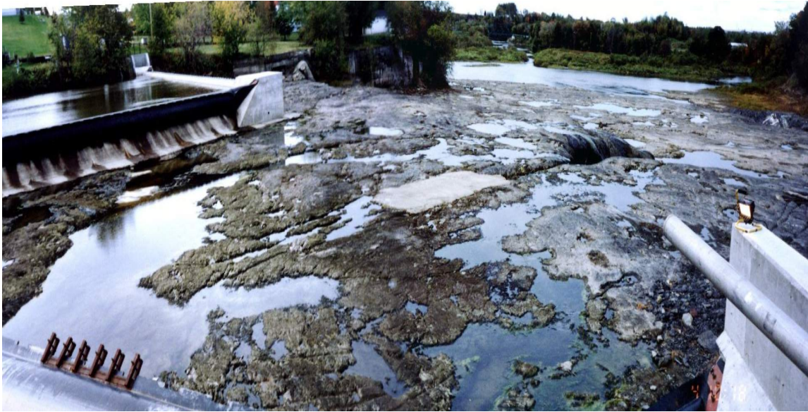
Rivière Nicolet Sud-Ouest asséchée par la centrale de Sainte-Brigitte-des-Saults.
