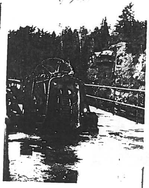
Photo No. 12.- Montrant un détail de l'outillage pour la manoeuvre des vannes au barrage de la chute du Pont Arnaud.
