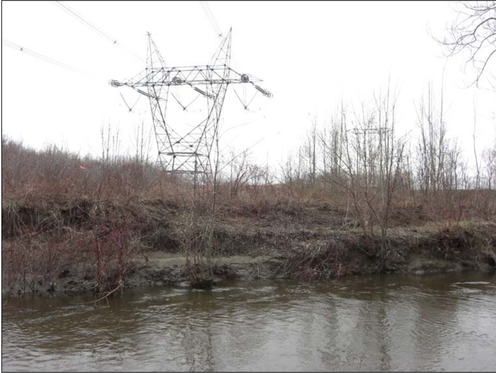
Photo 1 – Zone d'érosion du méandre situé au km 1,3.
