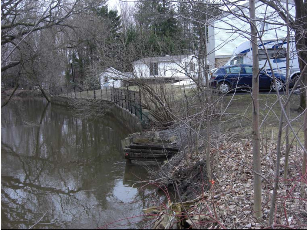
Photo 5 – Stabilisation par murêts de béton.
