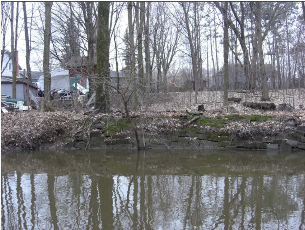
Photo 6 – Stabilisation par des blocs de béton.
