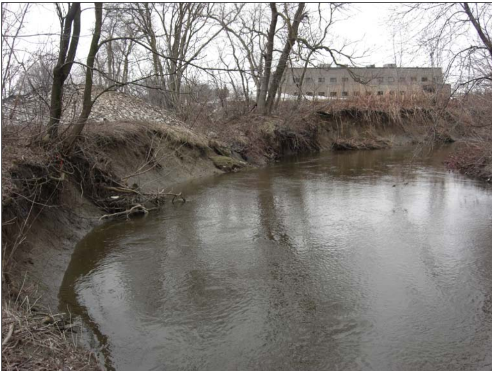
Photo 2 – Zone d'érosion importante située au méandre près du km 1,2.
