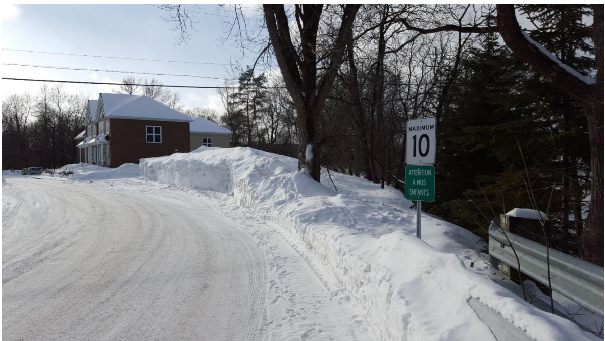
Figure QC-128-3 État actuel des lieux à l'extrémité nord de la rue Verlaine, où il est projeté par la ville de Québec de construire un rond de virée. La glissière de sécurité est située en haut de talus et c'est approximativement à cet endroit que débute la courbe de la rivière Lorette en amont du pont du boulevard Wilfrid-Hamel (vue vers l'amont).
