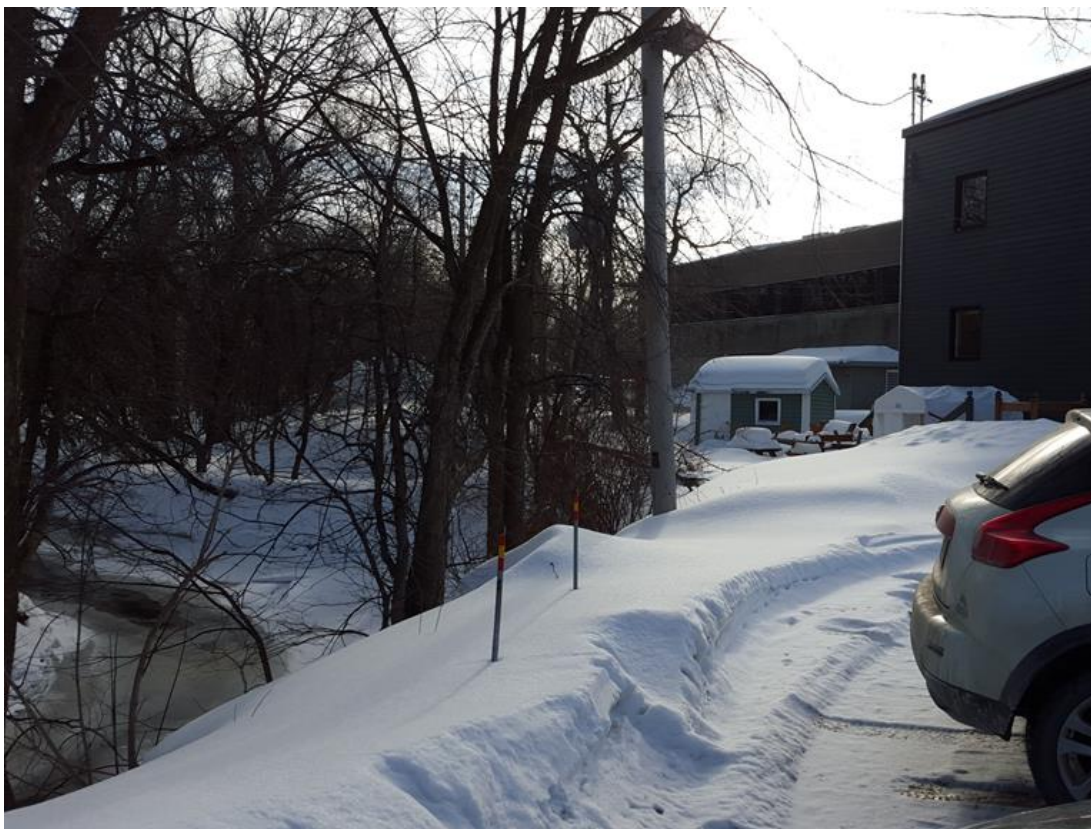
Figure QC-128-7 Secteur du PK 0+700, rive gauche. Vue vers l'amont de la rive où un mur de palplanches est projeté.
