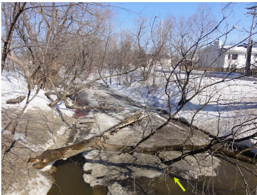
Photo 1 Arbres en aval du pont des Méandres le 12 mars 2012. Maintenant coupés.
