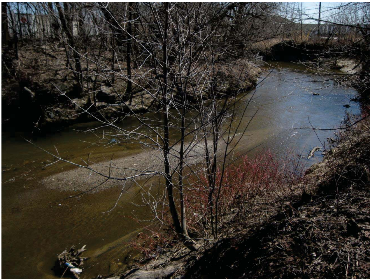
Figure 3.1 Secteur de faible profondeur avec seuils (avril 2016, PK 2,04, vue vers l'aval).
