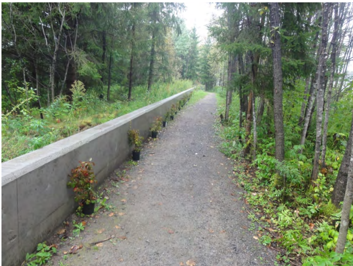
Figure 3-6 Exemple de mur de béton contre les inondations (Lac-Saint-Charles).
