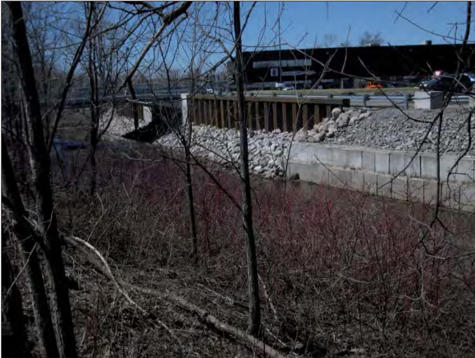
Photo 3 – Travaux de stabilisation en rive gauche de la rivière Lorette près du point kilométrique 2,7.
