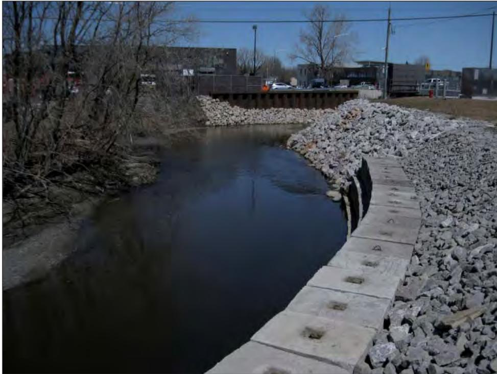
Photo 5 – Travaux de stabilisation en rive droite de la rivière Lorette près du point kilométrique 2,8.
