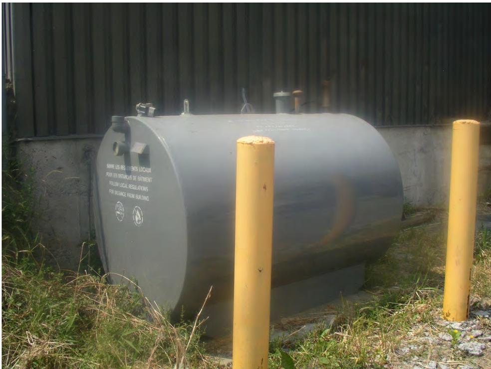
Photo 14 Lot 1 313 008 / Réservoir hors-sol (huile à chauffage).
