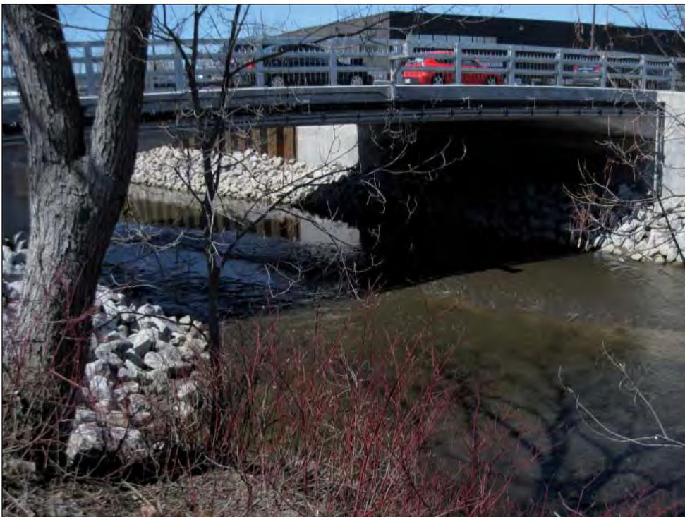
Photo 4 – Travaux de stabilisation sous le pont de la rue Michel-Fragasso.
