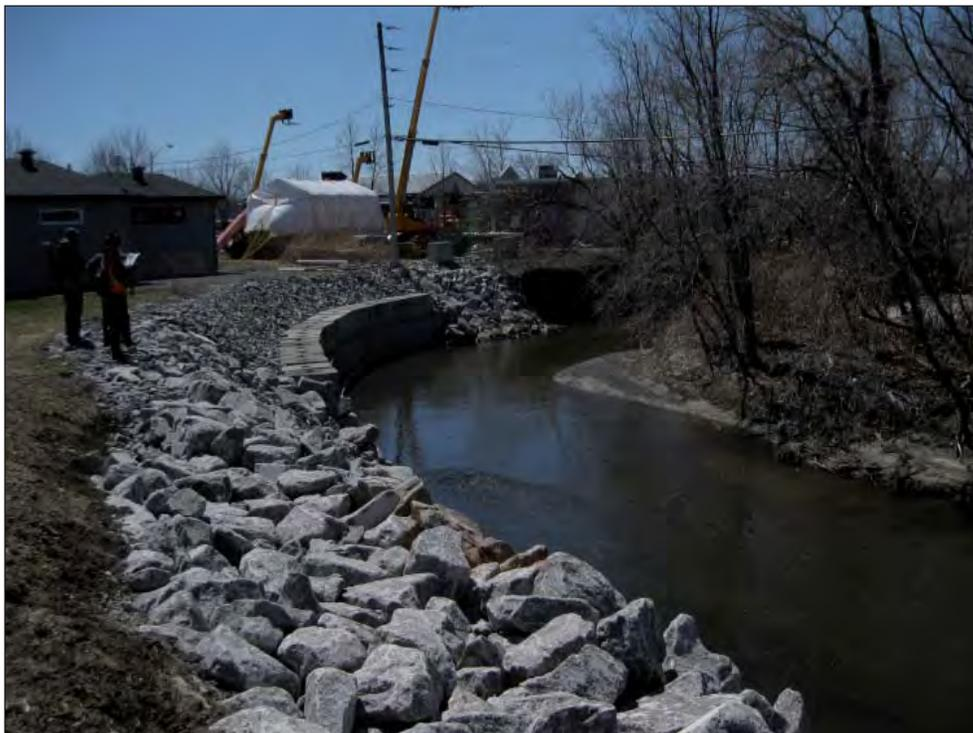
Photo 6 – Travaux de stabilisation en rive droite de la rivière Lorette près du point kilométrique 2,9.
