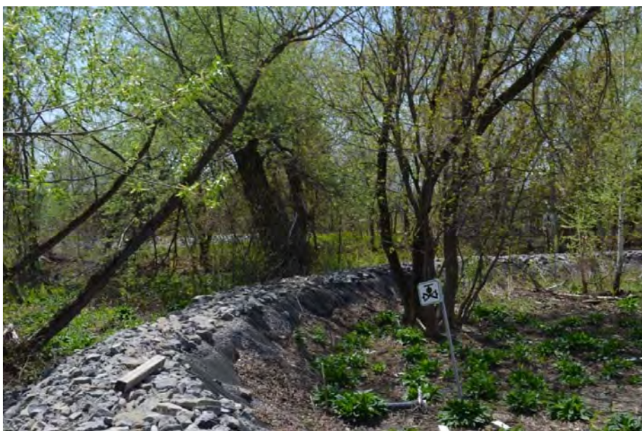
Figure 2.6 Interventions d'urgence en amont du pont des Méandres (avril 2016, PK 3,04, rive gauche)
