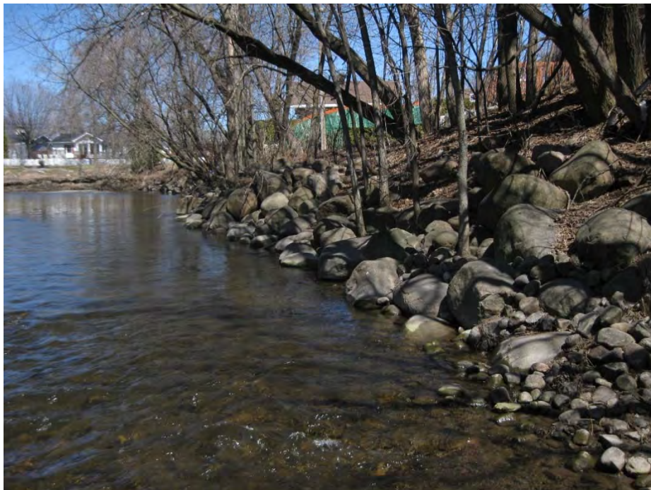
Figure 3.16 Remblai végétalisé (avril 2016, PK 3,74, rive gauche)
