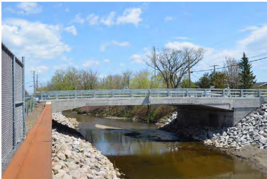
Figure 2.3 Pont des Méandres reconstruit en 2015 (mai 2016, PK 2,80, vue vers l'aval)
