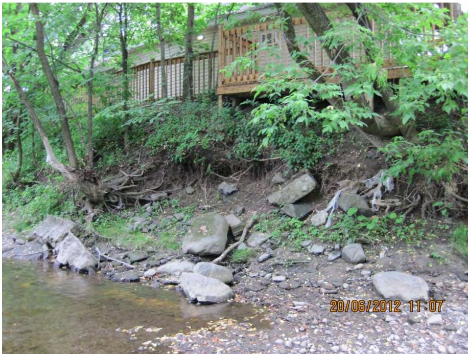
Figure 3.9 Érosion de la rive qui pourrait éventuellement causer des problèmes à certains bâtiments (juin 2012, PK 3,49, rive droite)
