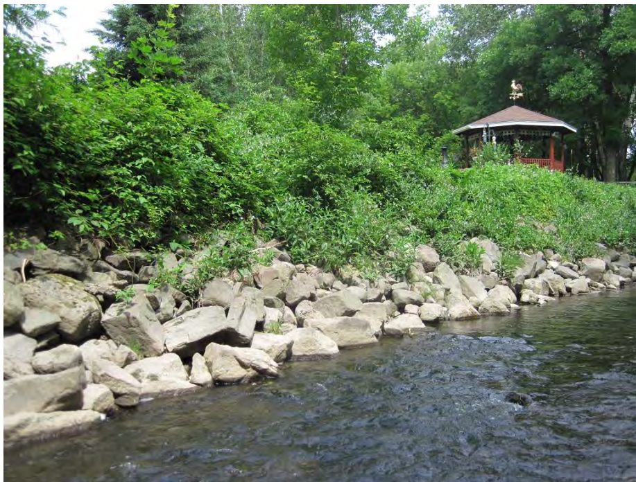
Figure 3.17 Enrochement végétalisé (juin 2012, PK 3,70, rive droite)
