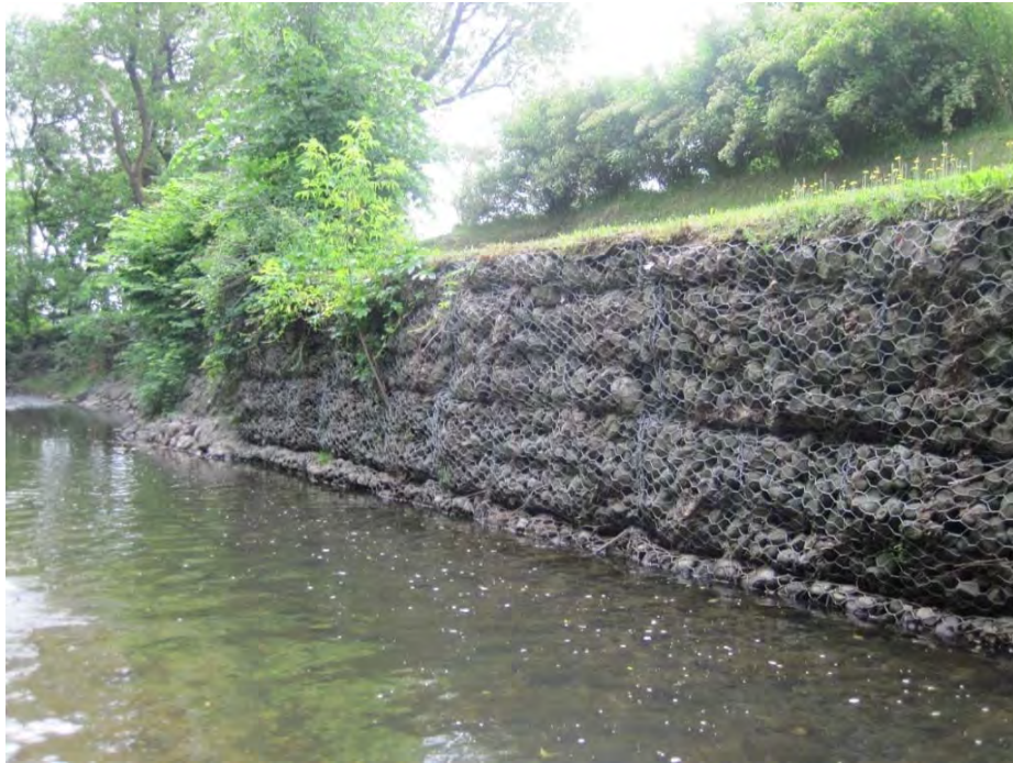
Figure 3.19 Mur de gabions (juin 2012, PK 3,65, rive droite)
