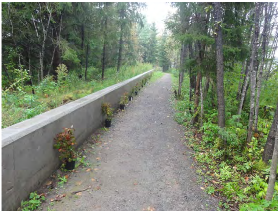
Figure 5.4 Exemple de mur en béton contre les inondations (Lac Saint-Charles)
