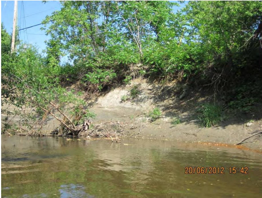
Figure 3.8 Érosion forte sur le tronçon à l'étude (juin 2012, PK 1,94, rive droite)
