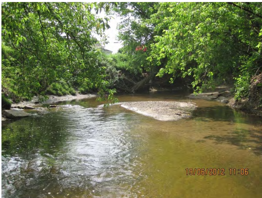
Figure 3.6 Un des secteurs de faible profondeur qui créent des seuils (juin 2012, PK 2,84, rive droite avant les travaux d'urgence de 2013)
