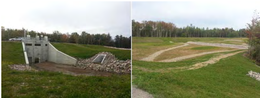
Figure 2.2 Barrages de régulation du ruisseau du Mont-Châtel (à gauche) et réservoir (à droite) (septembre 2015)
