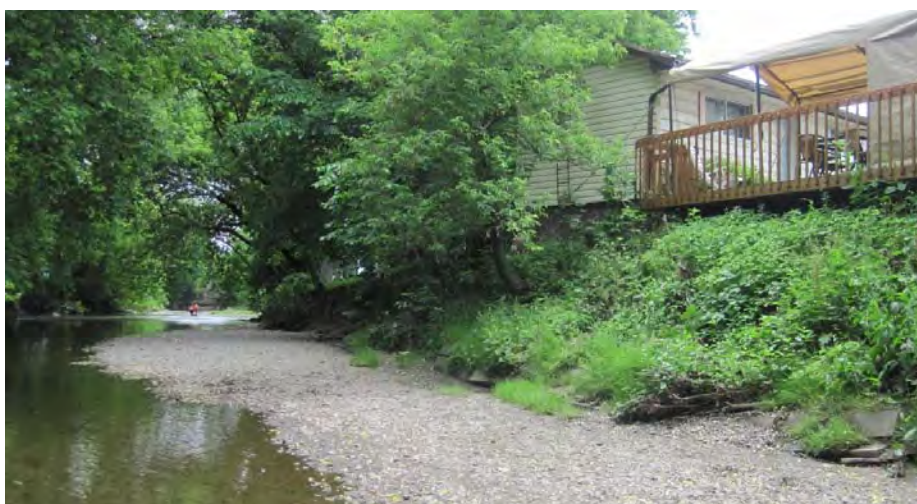
Figure 3.14 Conditions actuelles de la rive droite en bordure d'un motel (juin 2012, PK 3,46, rive droite)
