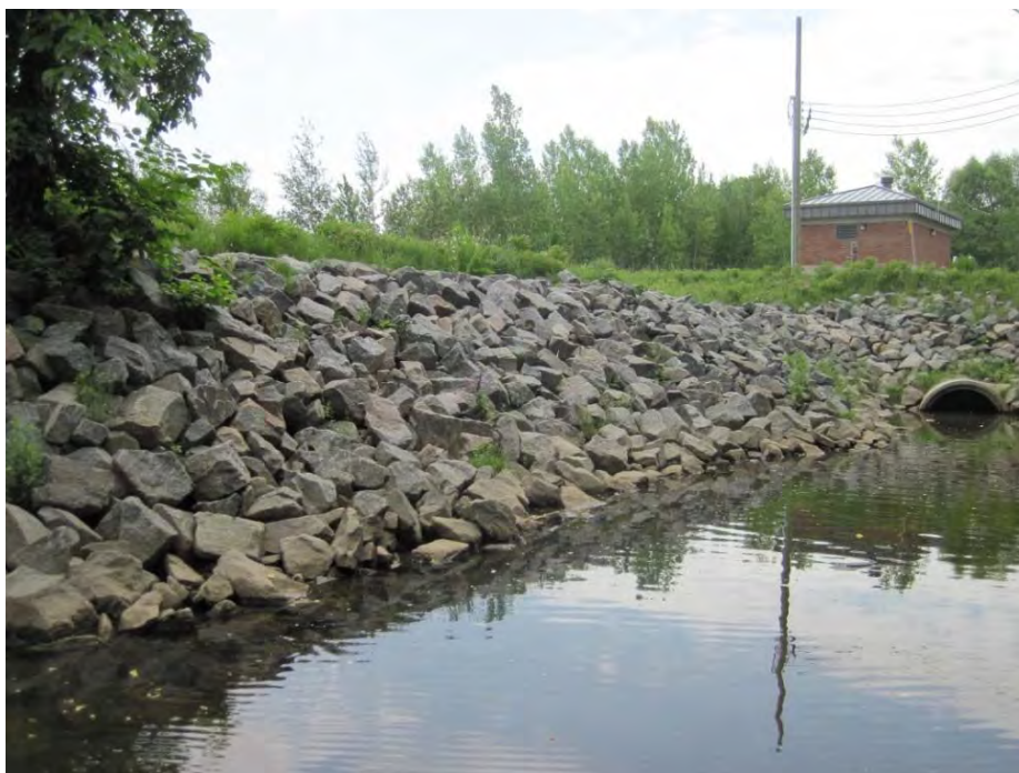
Figure 3.18 Enrochement non végétalisé (juin 2012, PK 3,05, rive droite)
