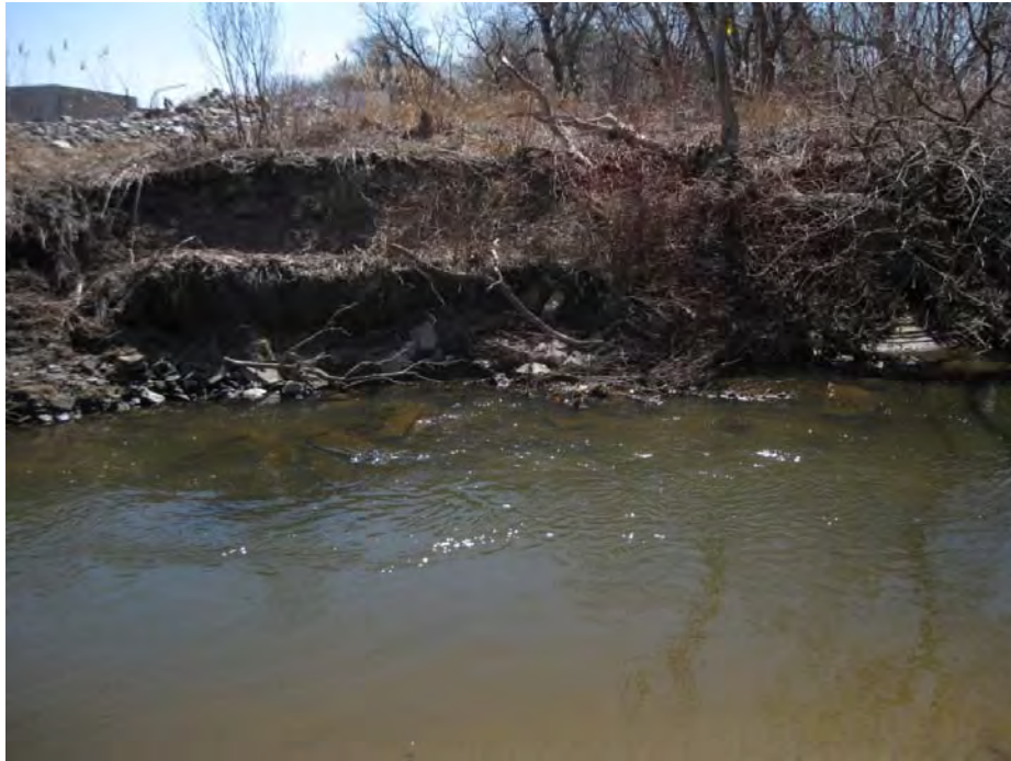
Figure 3.15 Conditions actuelles des rives (avril 2016, PK 2,40, rive gauche)
