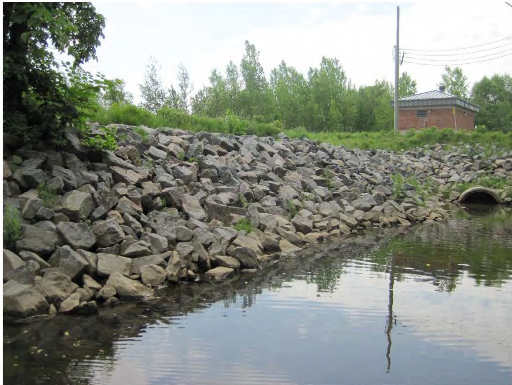
Figure 3.18 Enrochement non végétalisé
