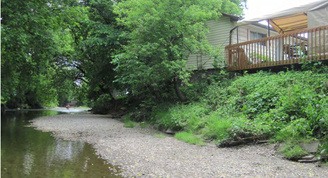
Figure 3.14 Conditions actuelles de la rive droite en bordure d'un motel (PK 3,46)
