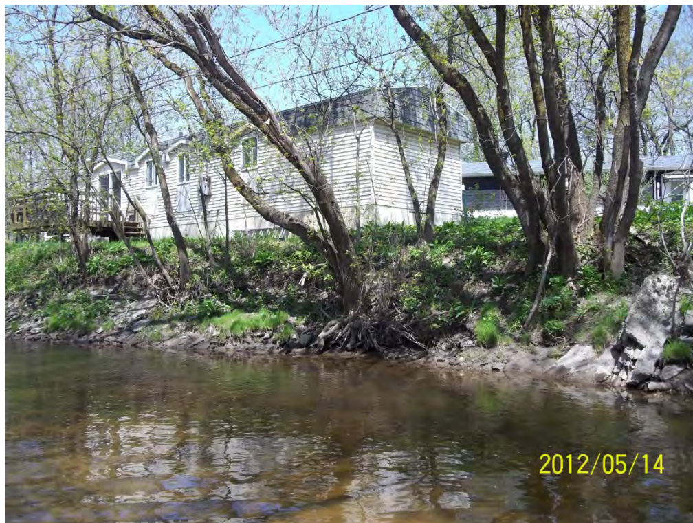
Infrastructures existantes (PK 3,10, rive gauche).
