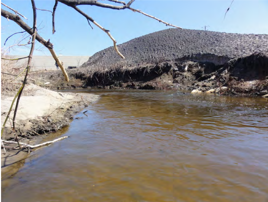
Dépôt de neige et altération des rives en rive gauche, point de débordement (PK 2,40, vue amont).
