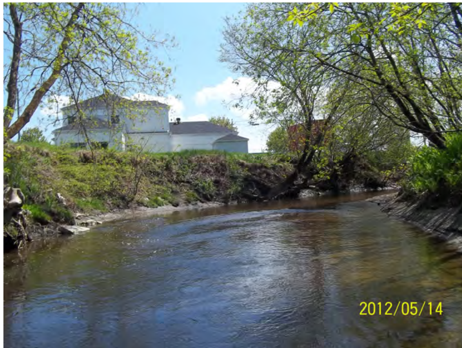
Érosion des rives et présence d'arbre sous le niveau de la crue 2 ans, dans la courbe en amont du pont de la rue Michel-Fragasso (PK 2,83, vue vers l'amont).
