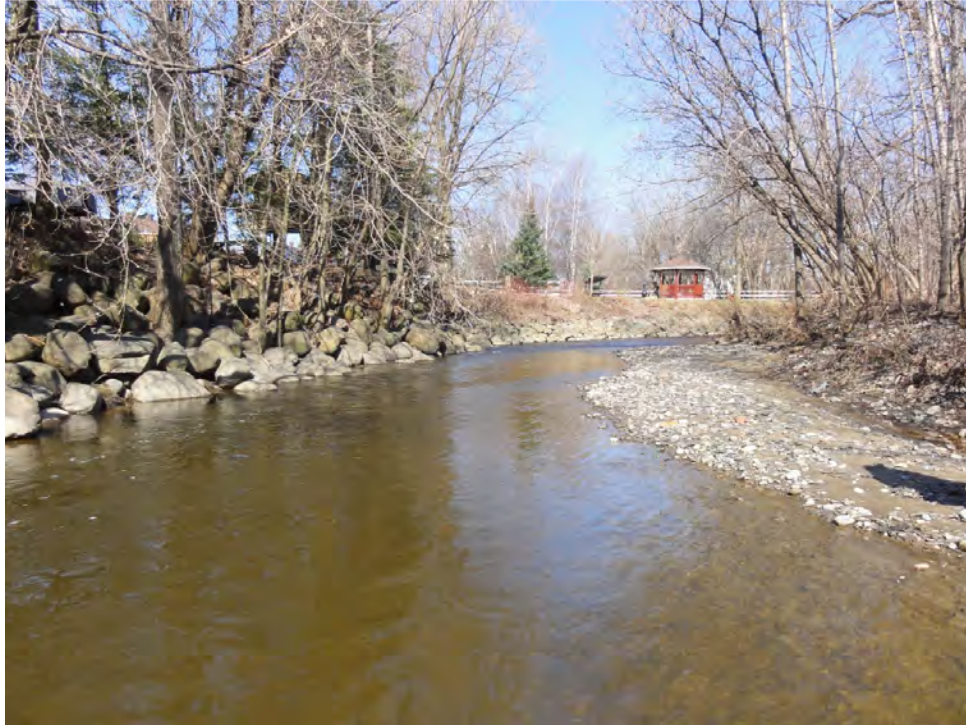
Zone de dépôt à l'intérieur de la courbe et enrochement à conserver en rive droite (PK 3,72, vue vers l'amont).
