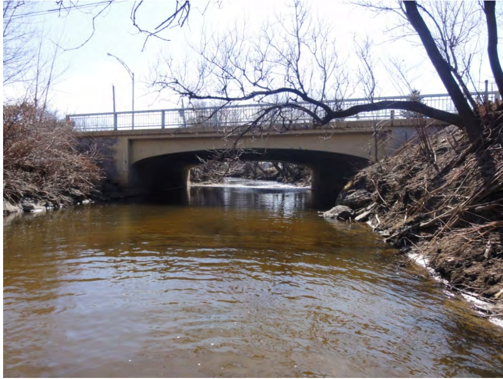
Photo 14 Pont Wilfrid-Hamel Ouest, vue vers l'aval.
