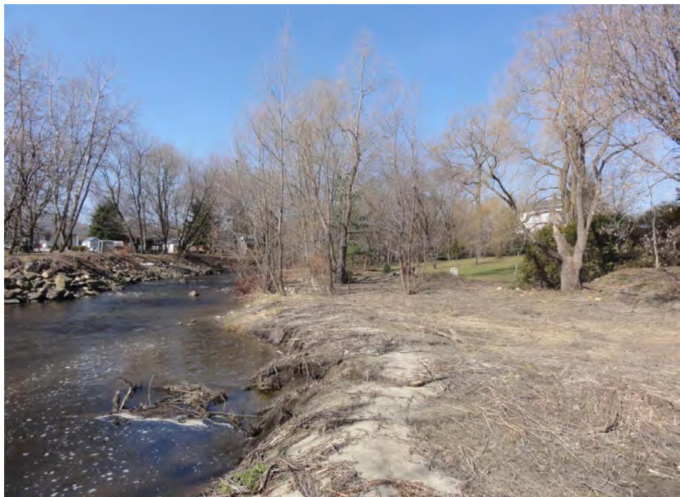
Photo 8 Courbe du PK 3,78, vue de la rive gauche vers l'amont (zone de débordement 4).
