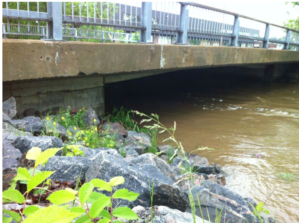
Photo 17 Pont de la rue Michel-Fragasso, de la rive gauche aval (débit approximatif de 22 m 3 /s).
