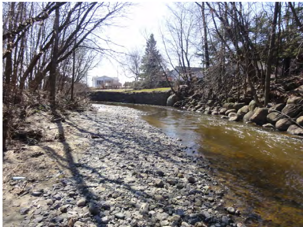
Présence de dépôts de calibre important à l'intérieure de la courbe en rive droite et mur de gabion existant à conserver en rive gauche (PK 3,68, rive gauche, vue vers l'aval).
