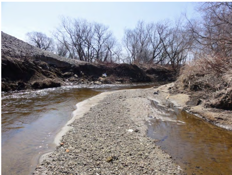
Photo 2 Accumulation de sédiments et érosion en rive gauche PK 2,40, secteur Saint-Jean-Baptiste (vue vers l'aval).
