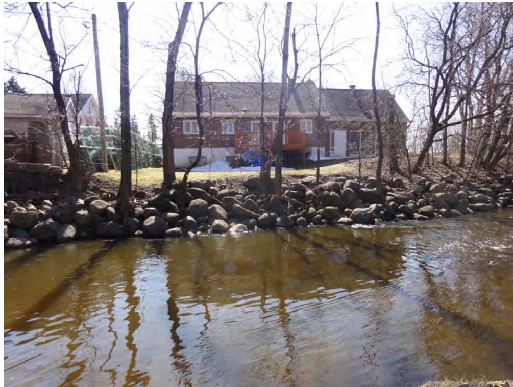
Enrochements à conserver (PK 3,74, rive droite).
