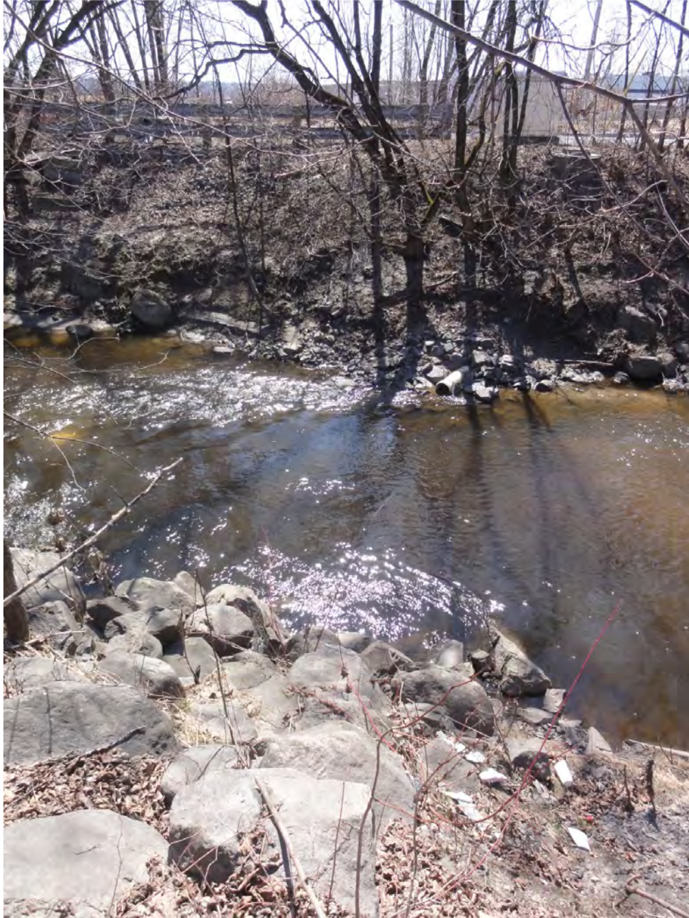
Rétrécissement et contrôle hydraulique (PK 2,56, rive gauche).
