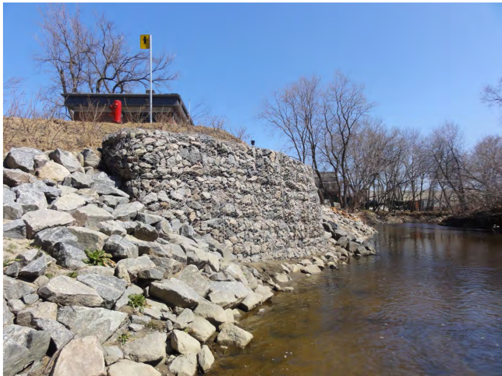
Photo 11 Secteur Michel-Fragasso, murets existants à conserver (PK 2,50).
