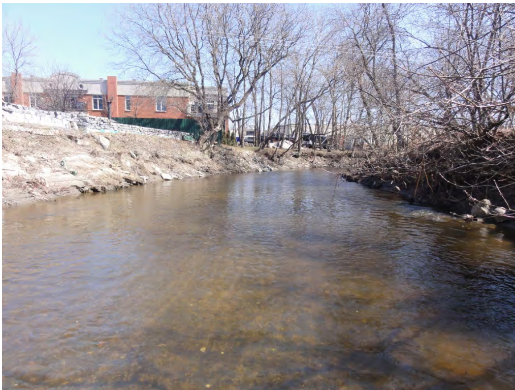
Muret de protection existant en rive gauche (PK 2,46, vue vers l'aval).
