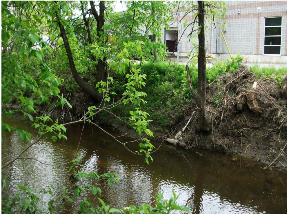
Photo 7 PK 2,63, vue vers la rive gauche (zone de débordement 1).
