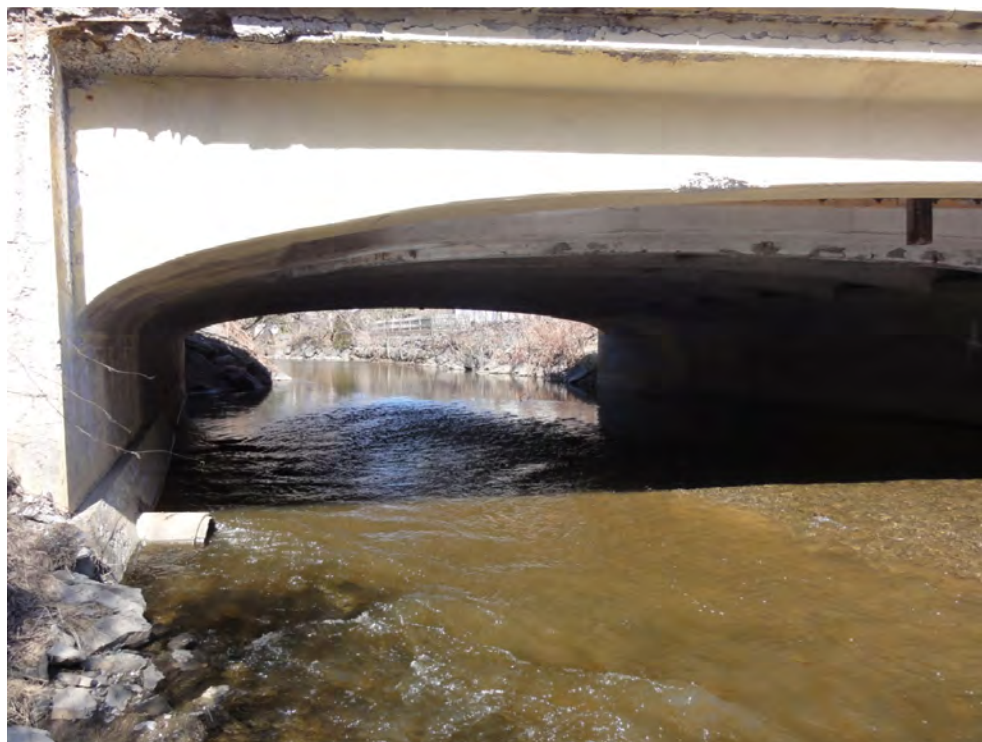
Contrôle hydraulique sous le pont Hamel Ouest, vue vers l'amont.
