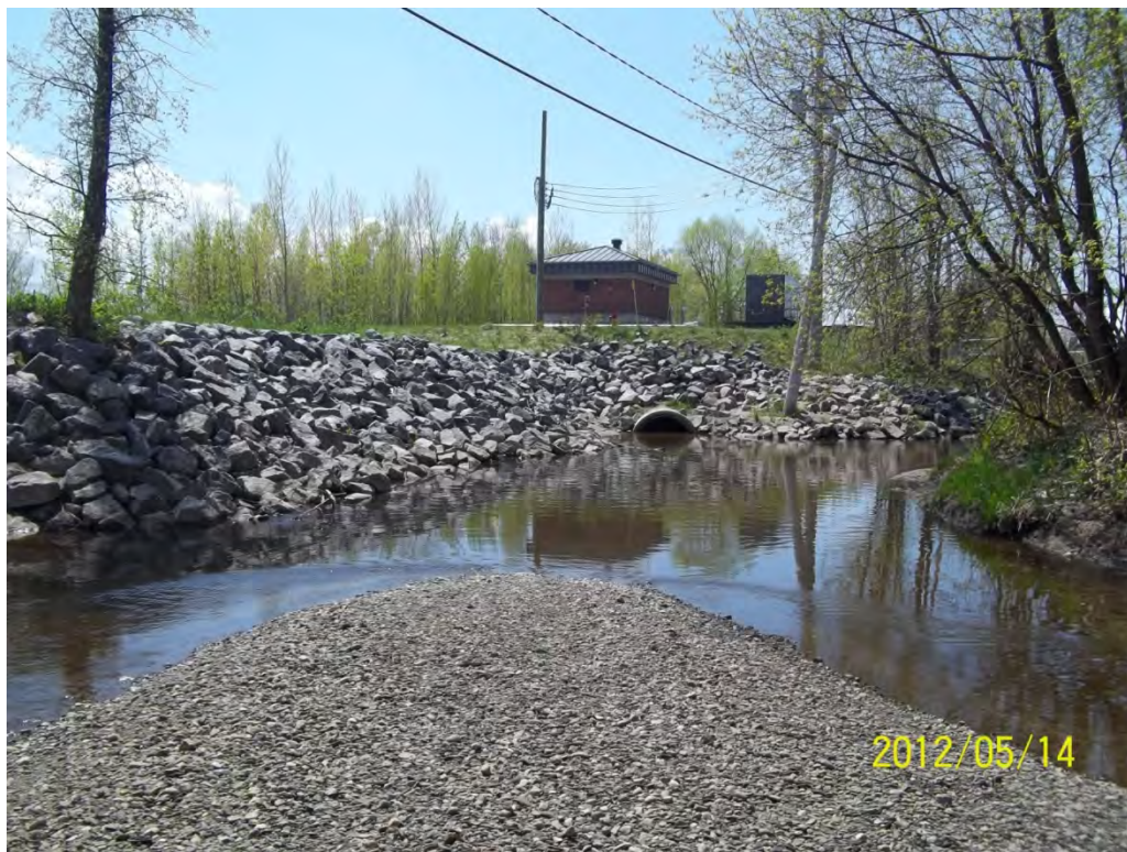
Photo 6 Vue vers le PK 3,06, poste de pompage Rideau, vers l'amont (zone de débordement 1).
