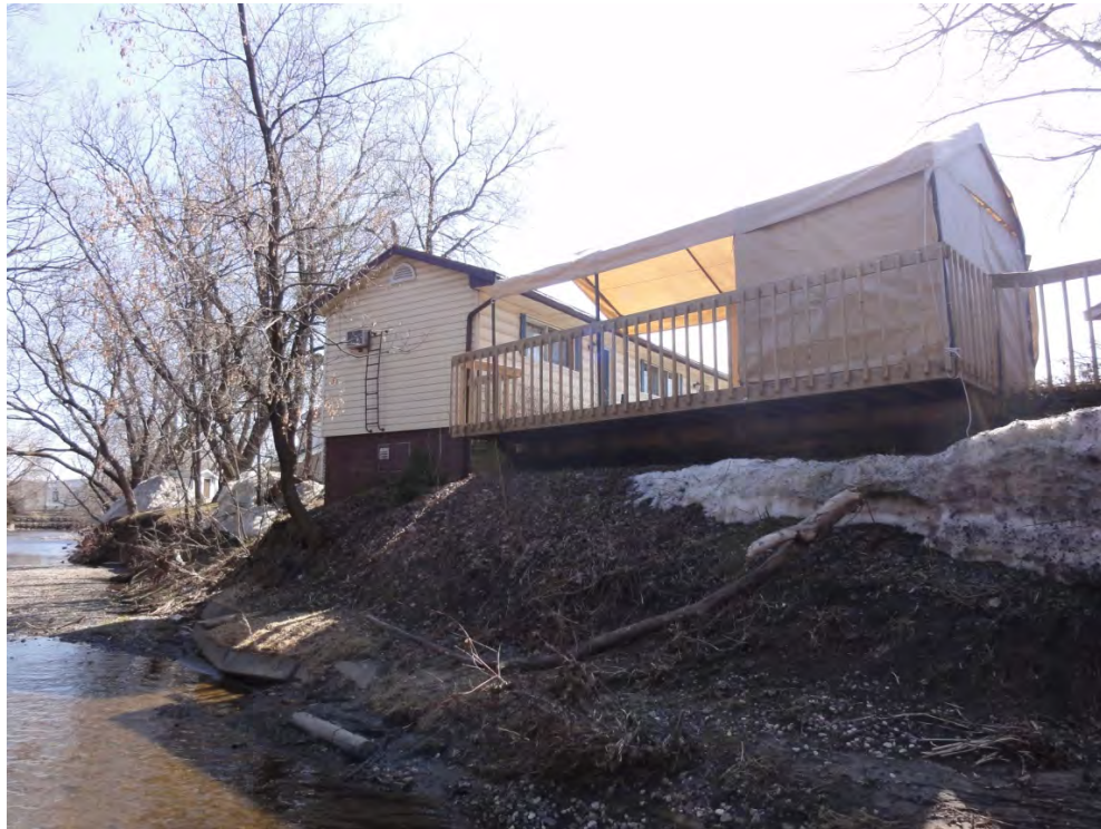
Photo 16 PK 3,34 (vue vers l'aval).
