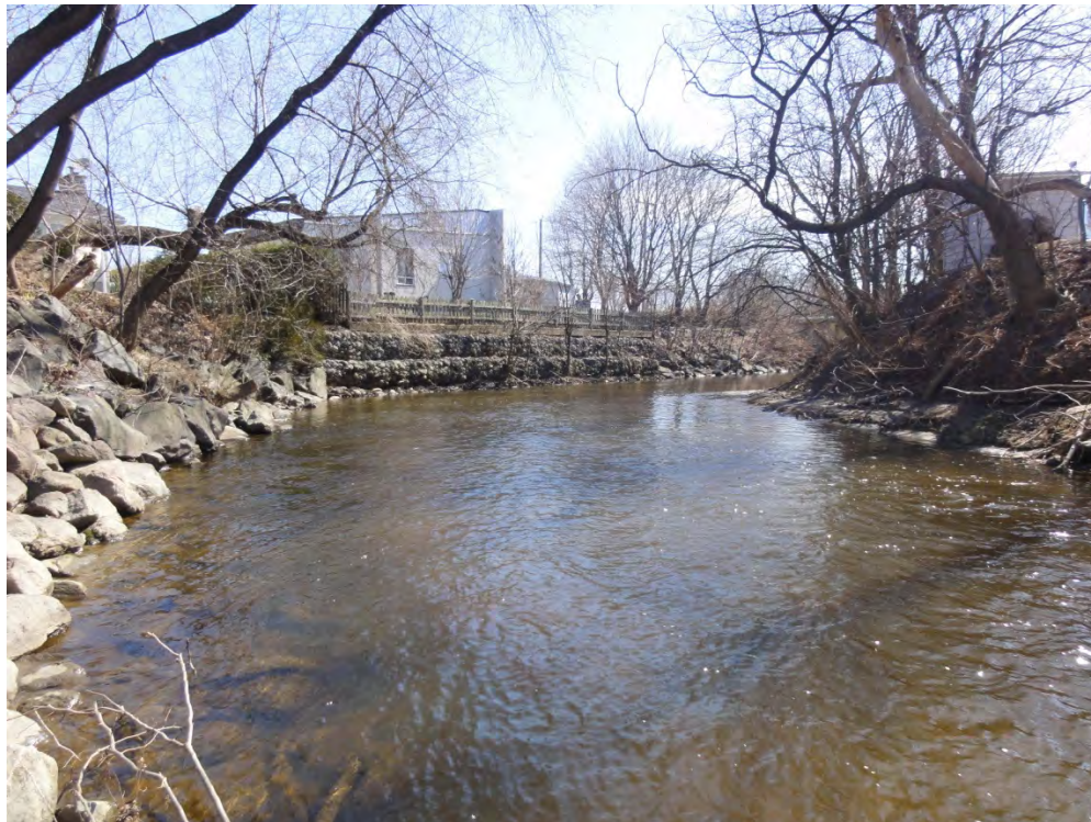
Courbe en amont du pont du boulevard Wilfrid-Hamel, murets existants à conserver en rive gauche (PK 3,34, vue vers l'aval).
