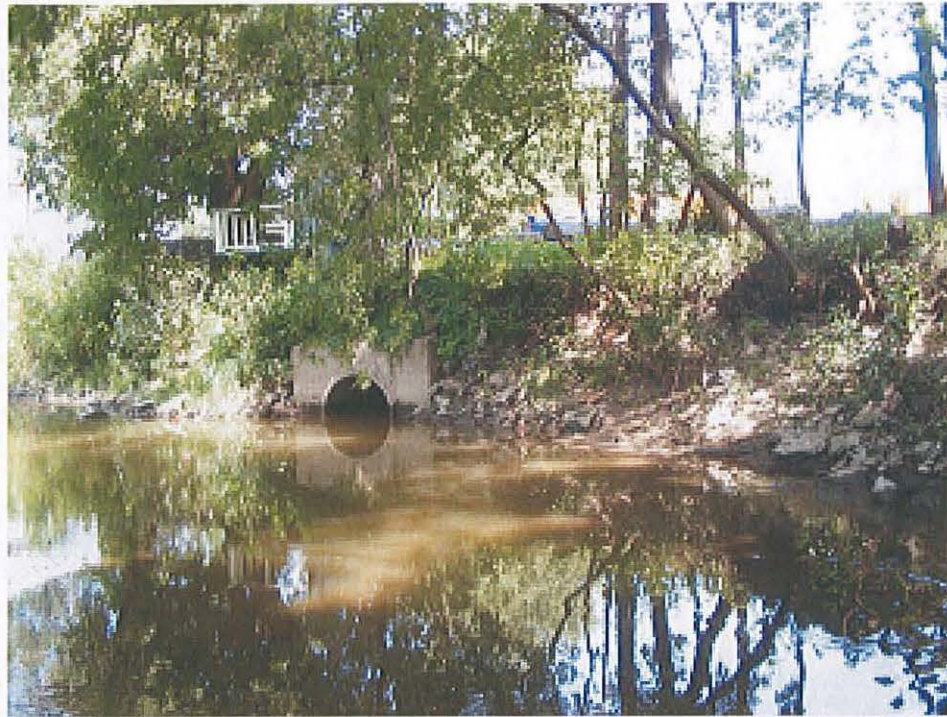
Photo 4.3 : Exutoire pluvial existant
