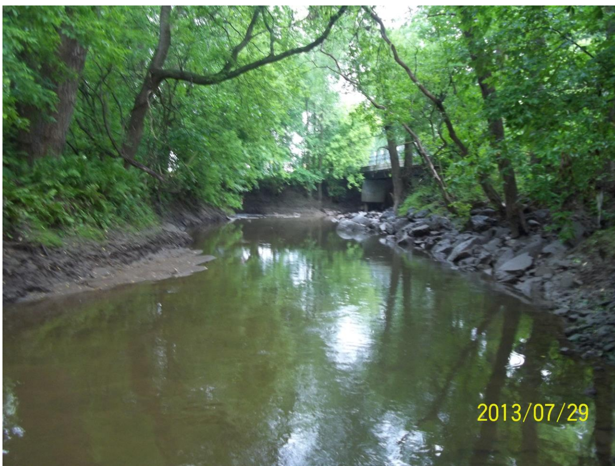
Figure B2-6A1 Rivière Lorette en amont du pont du boulevard Masson. Courbe à 90° juste en amont du pont. Vue vers l'aval.
