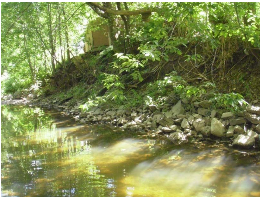
Photo 4 : Vue générale de l'enrochement #4 de la rivière Lorette.
