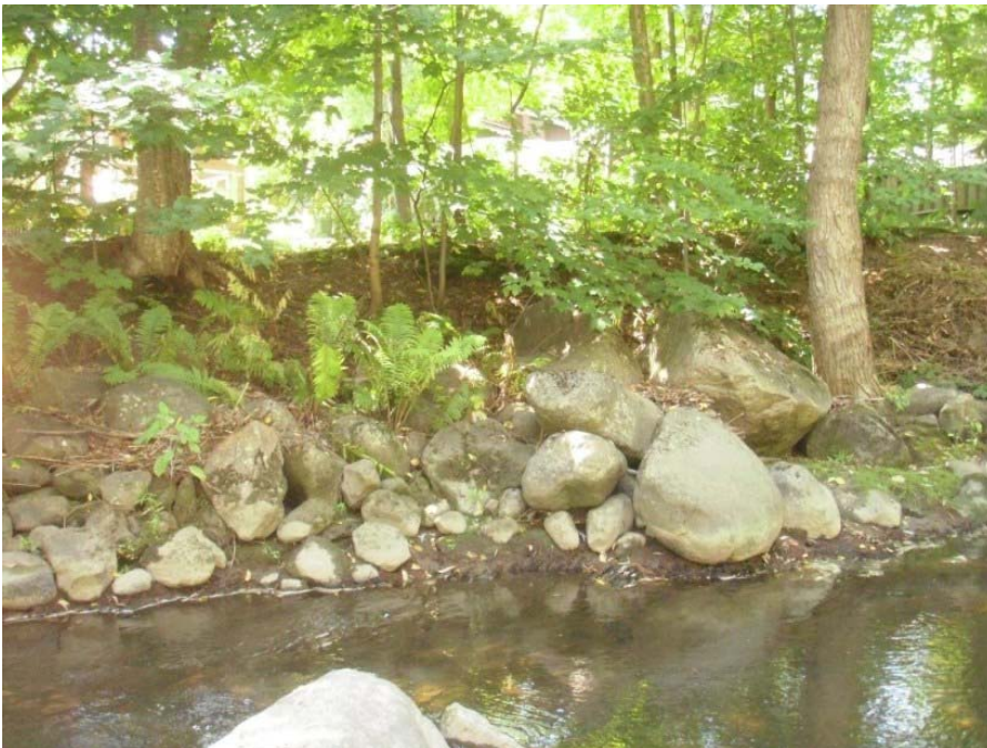
Photo 14 : Vue générale de l'enrochement #13 de la rivière Lorette.
