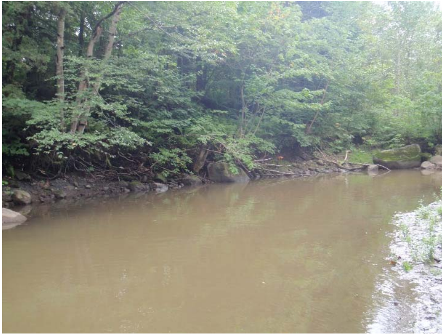
Photo 61 : Vue générale de la zone d'érosion ER-031 de la rivière Lorette.
