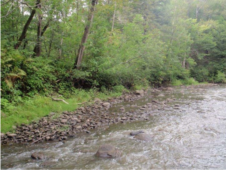
Photo 59 : Vue générale de la zone d'érosion ER-029 de la rivière Lorette.
