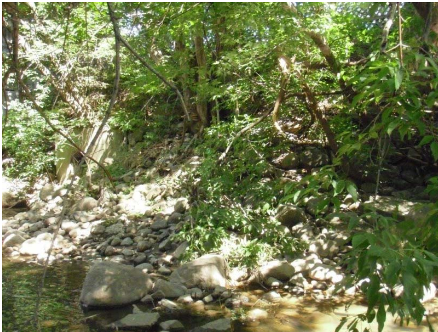
Photo 8 : Vue générale de l'enrochement #8 de la rivière Lorette.
