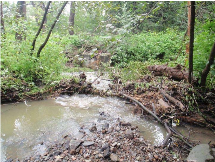
Photo 112 : Vue générale de la zone d'érosion ER-ND-20 du ruisseau Notre-Dame.
