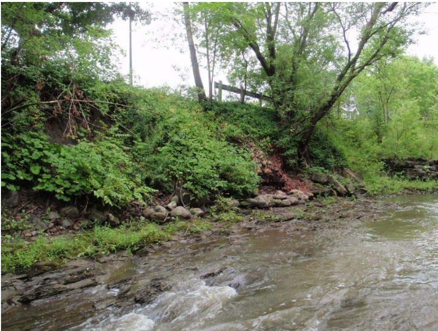
Photo 40 : Vue générale de la zone d'érosion ER-010 de la rivière Lorette.
