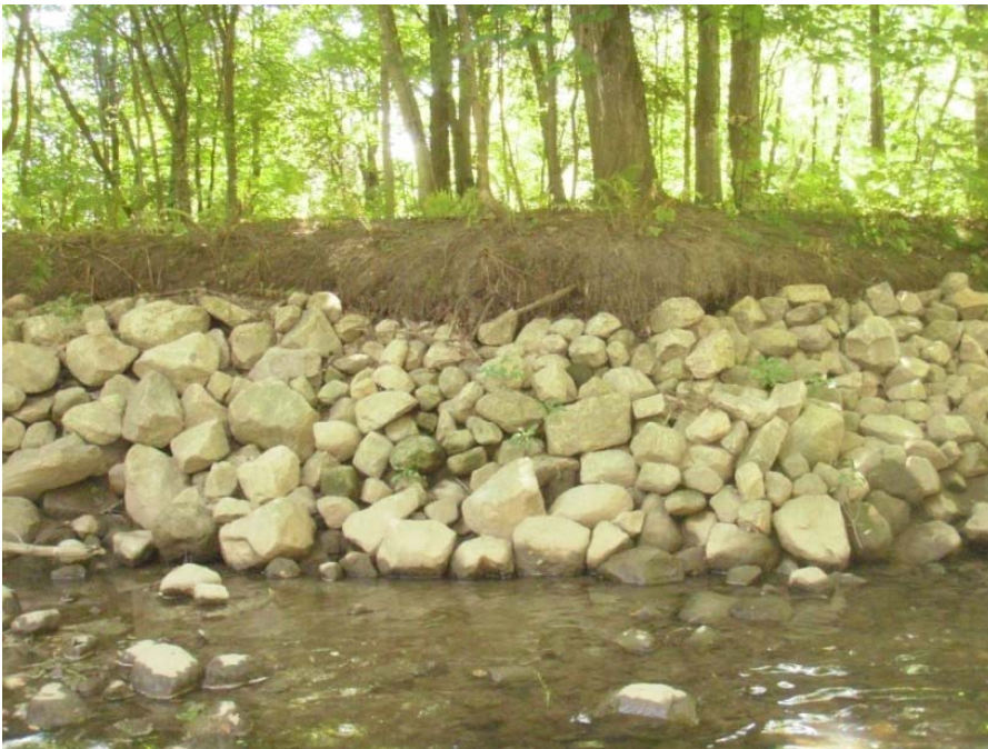
Photo 28 : Vue générale de l'énrochement #25 de la rivière Lorette.
