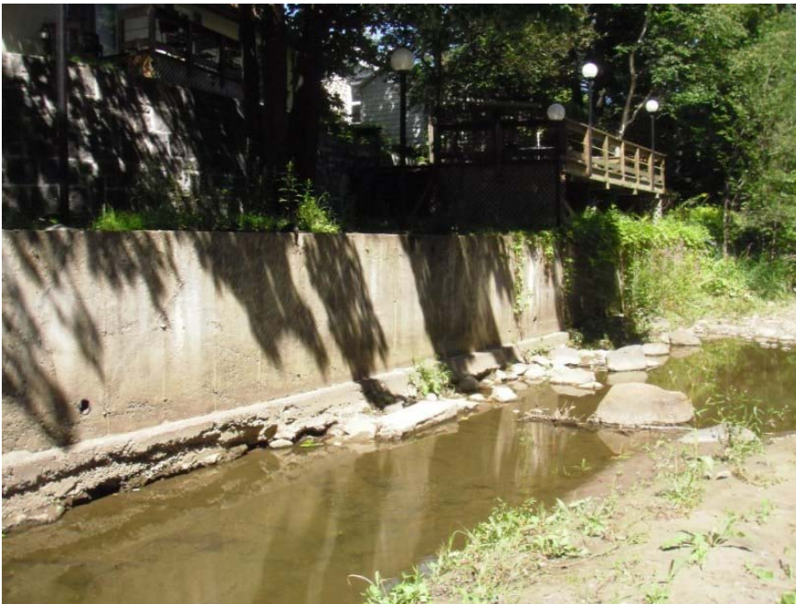
Photo 20 : Vue générale de l'énrochement #18 de la rivière Lorette.
