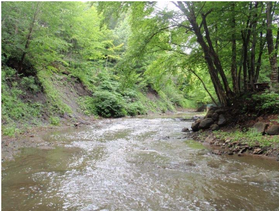
Photo 52 : Vue générale de la zone d'érosion ER-022 de la rivière Lorette.
