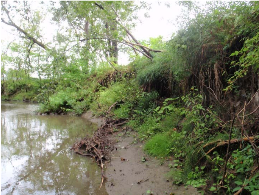
Photo 31 : Vue générale de la zone d'érosion ER-01 de la rivière Lorette.
