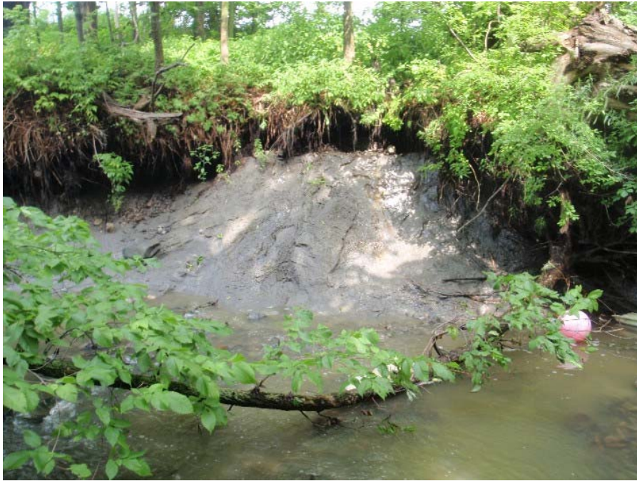
Photo 119 : Vue générale de la zone d'érosion ER-ND-27 du ruisseau Notre-Dame.
