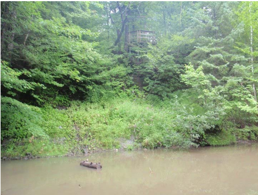
Photo 74 : Vue générale de la zone d'érosion ER-045 de la rivière Lorette.
