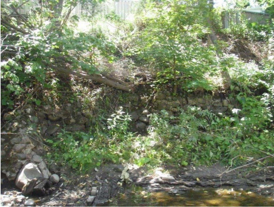
Photo 15 : Vue générale de l'énrochement #14 de la rivière Lorette.
