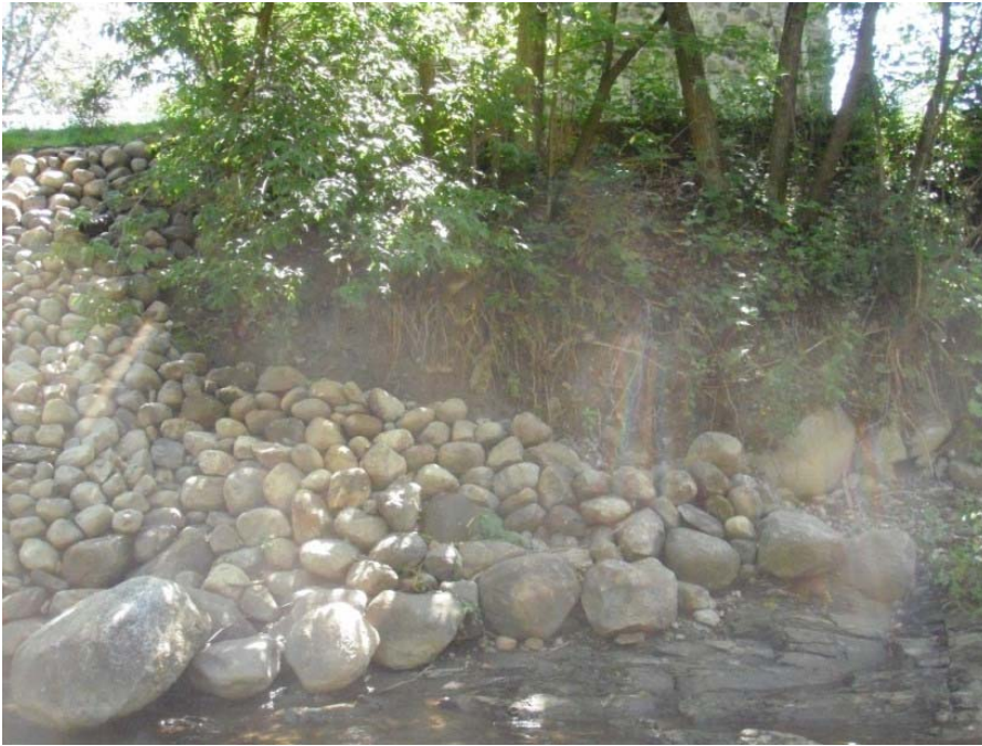
Photo 11 : Vue générale de l'enrochement #10 de la rivière Lorette.
