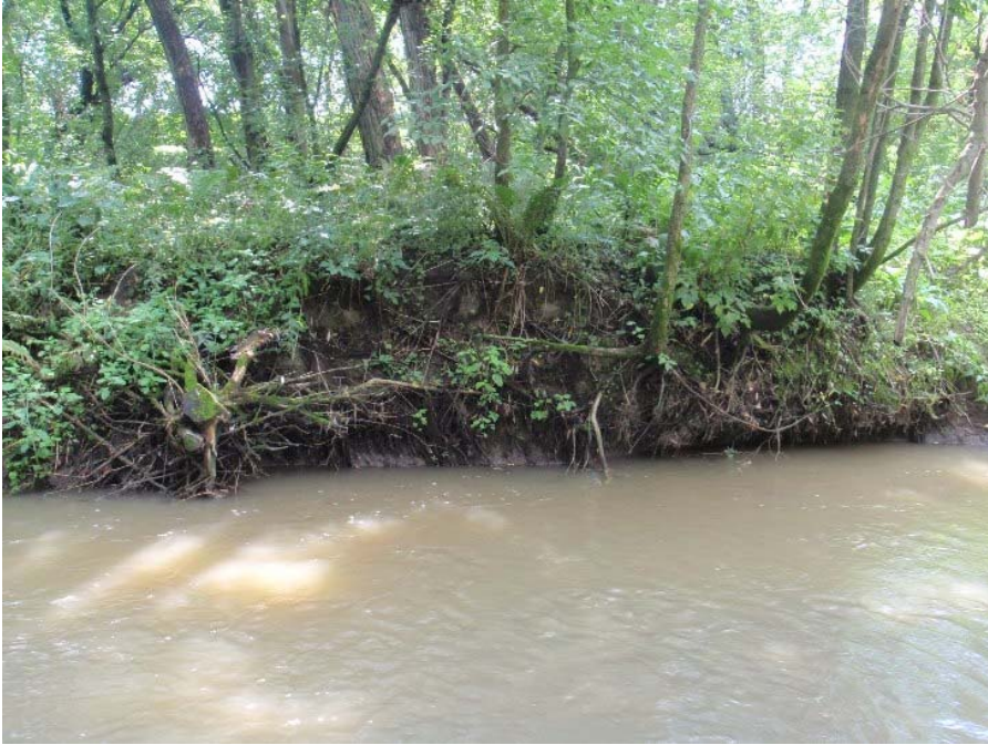
Photo 89 : Vue générale de la zone d'érosion ER-064 de la rivière Lorette.
