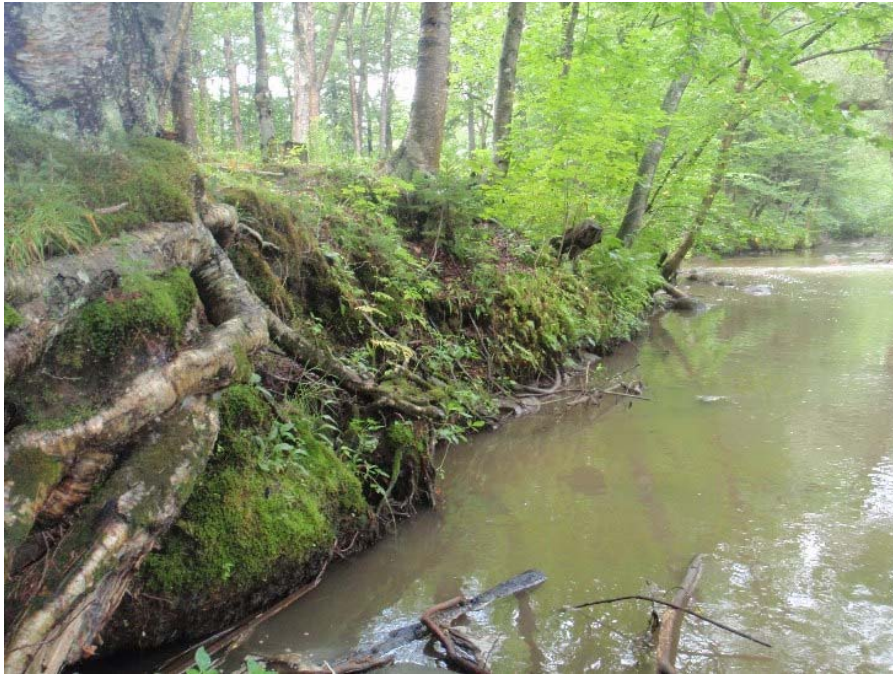
Photo 79 : Vue générale de la zone d'érosion ER-050 de la rivière Lorette.
