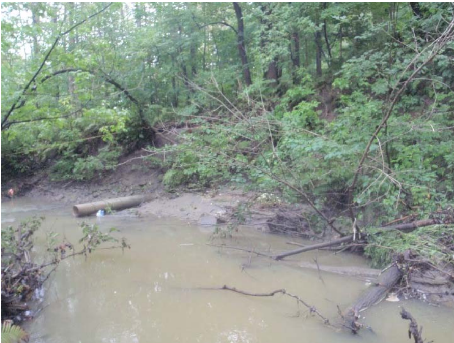
Photo 102 : Vue générale de la zone d'érosion ER-ND-6 du ruisseau Notre-Dame.
