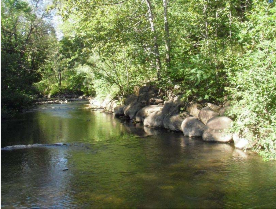
Photo 27 : Vue générale de l'énrochement #24 de la rivière Lorette.
