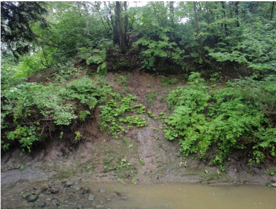
Photo 110 : Vue générale de la zone d'érosion ER-ND-18 du ruisseau Notre-Dame.
