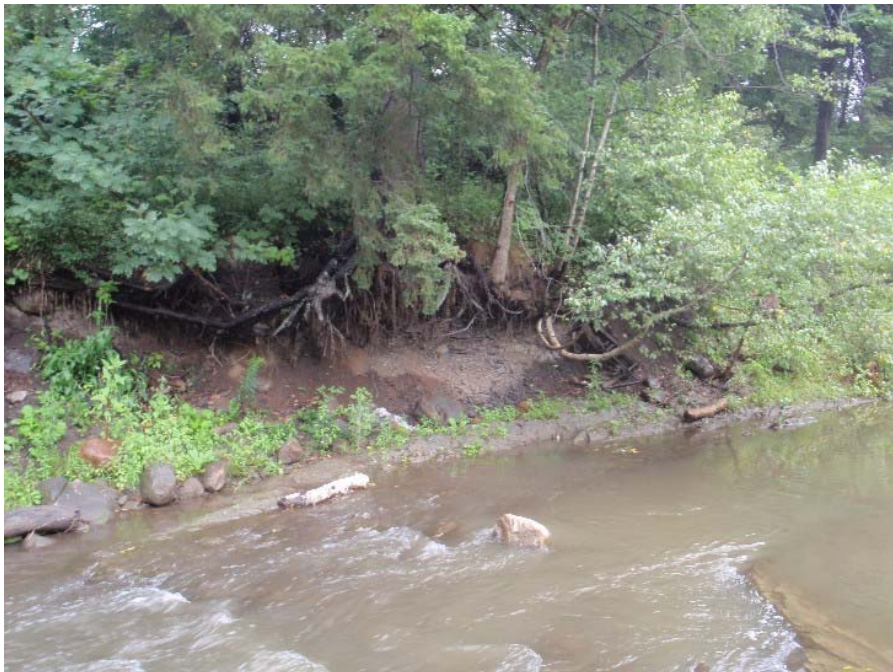
Photo 64 : Vue générale de la zone d'érosion ER-034 de la rivière Lorette.
