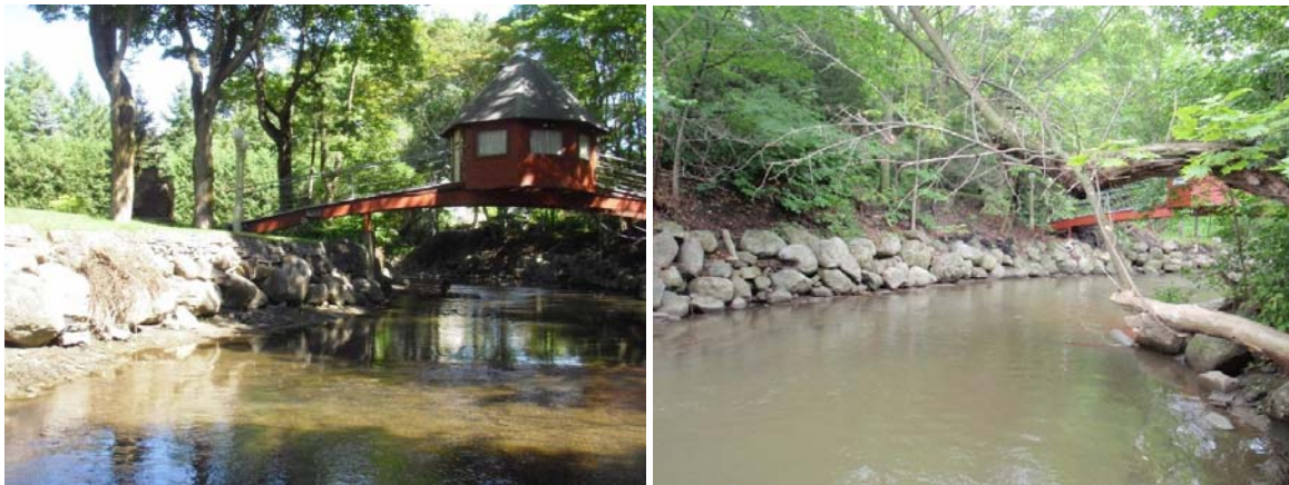
Photo 24 : Vue générale de l'enrochement #21b de la rivière Lorette.
