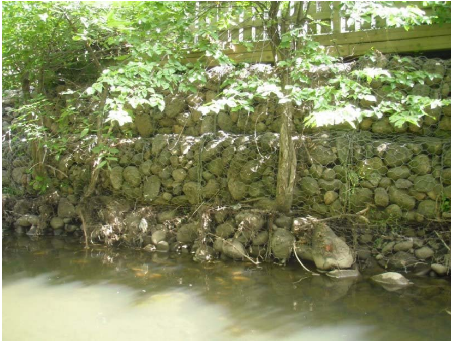
Photo 3 : Vue générale de l'enrochement #3 de la rivière Lorette.
