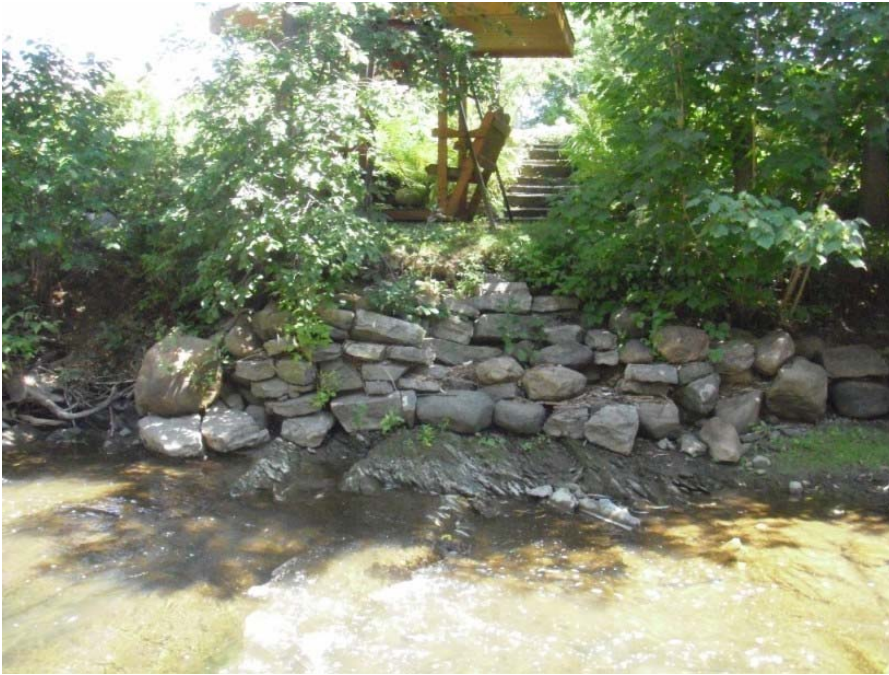
Photo 13 : Vue générale de l'enrochement #12 de la rivière Lorette.
