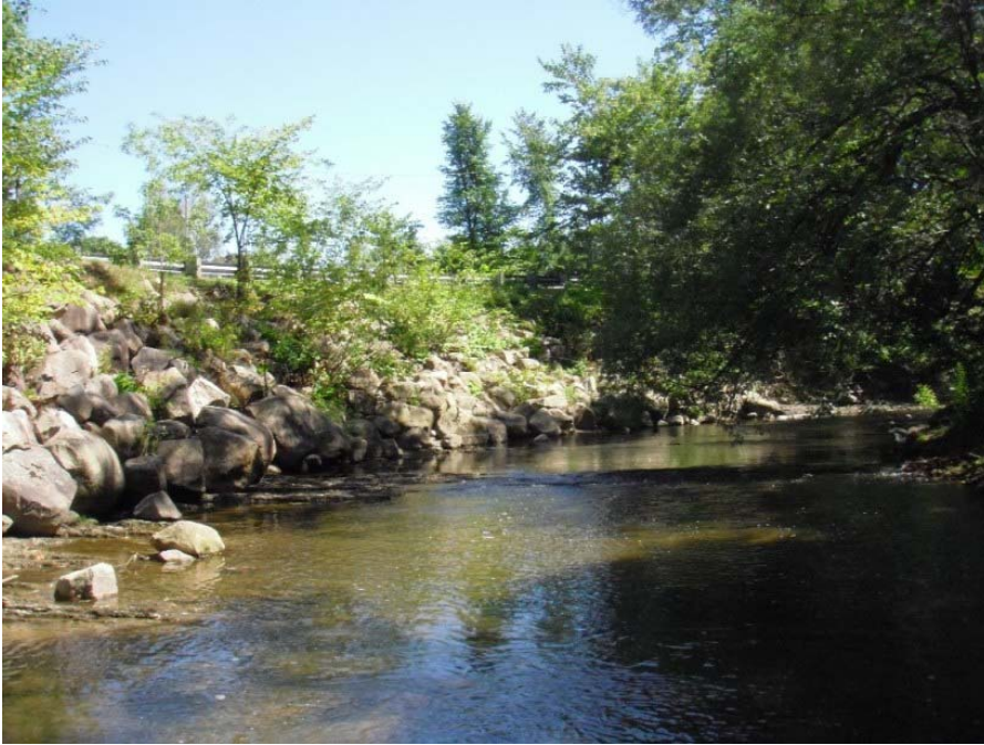
Photo 19 : Vue générale de l'énrochement #17 de la rivière Lorette.
