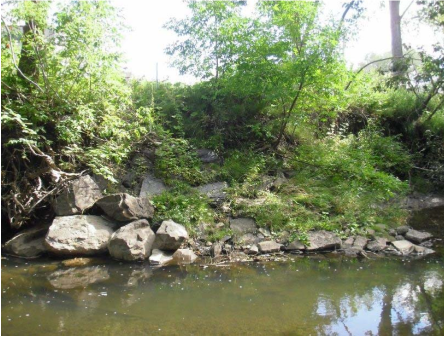
Photo 1 : Vue générale de l'énrochement #1 de la rivière Lorette.
