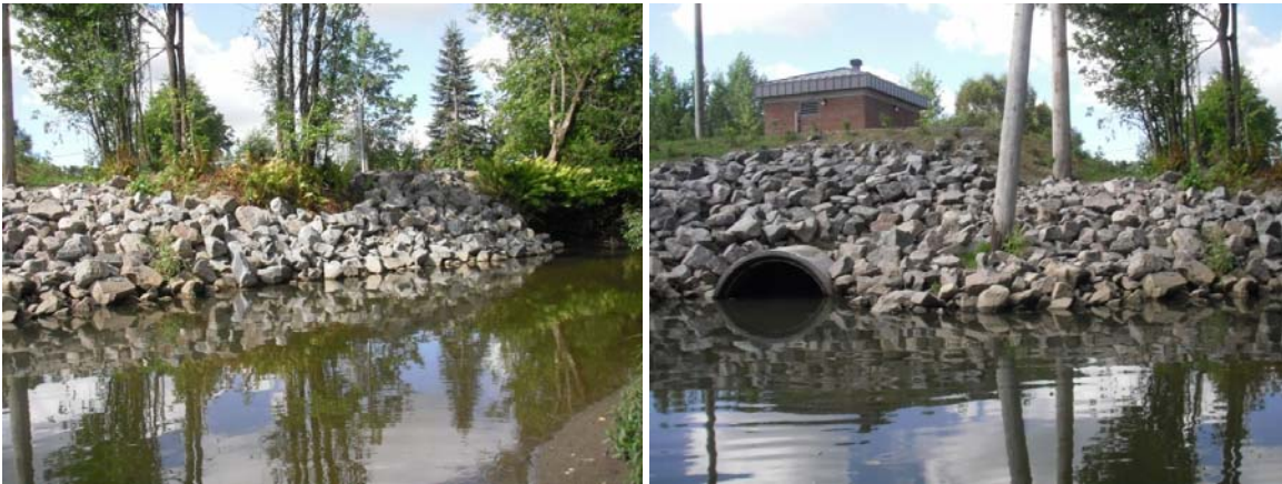
Photo 2 : Vue générale de l'énrochement #2 de la rivière Lorette.
