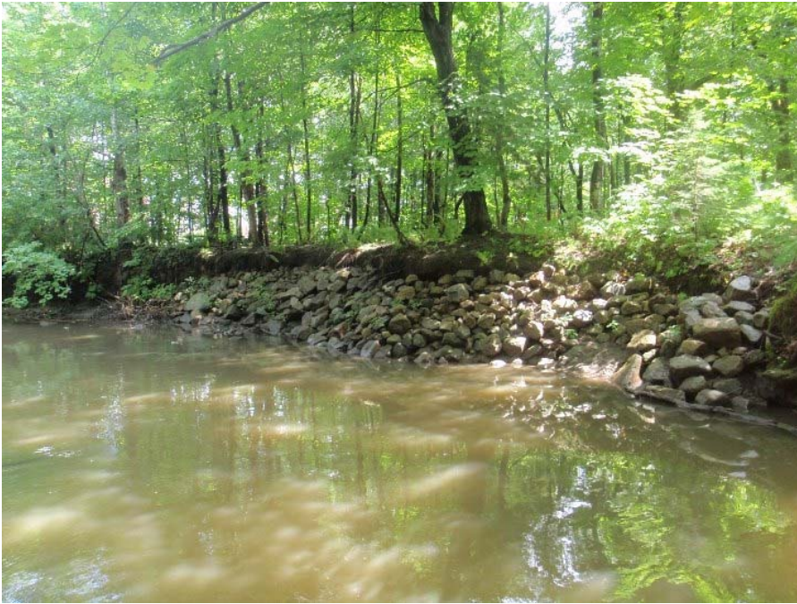
Photo 29 : Vue générale de l'engrochement #26 de la rivière Lorette.
