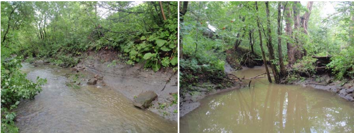
Photo 118 : Vue générale de la zone d'érosion ER-ND-26 du ruisseau Notre-Dame.
