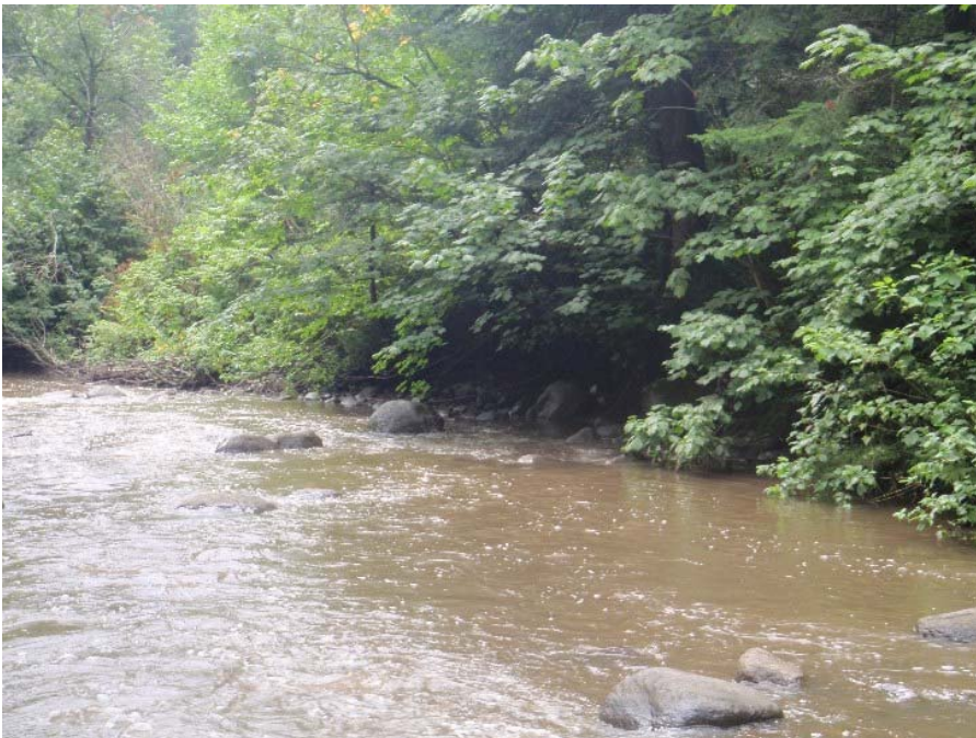
Photo 68 : Vue générale de la zone d'érosion ER-038 de la rivière Lorette.
