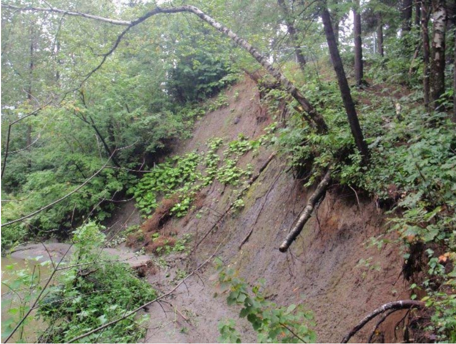
Photo 107 : Vue générale de la zone d'érosion ER-ND-15 du ruisseau Notre-Dame.
