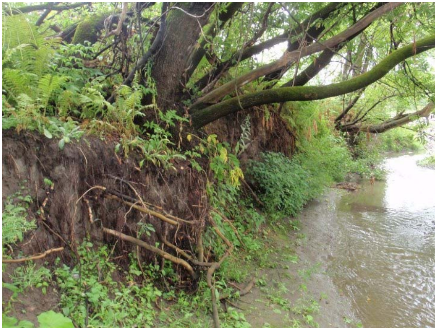
Photo 32 : Vue générale de la zone d'érosion ER-02 de la rivière Lorette.
