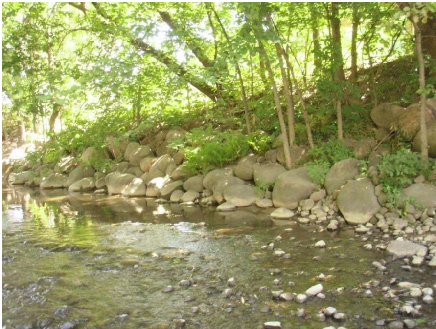
Photo 6 : Vue générale de l'enrochement #6 de la rivière Lorette.
