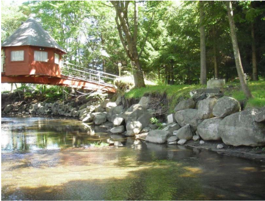
Photo 23 : Vue générale de l'enrochement #21a de la rivière Lorette.
