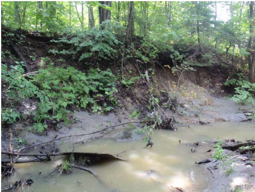
Photo 124 : Vue générale de la zone d'érosion ER-ND-33 du ruisseau Notre-Dame.
