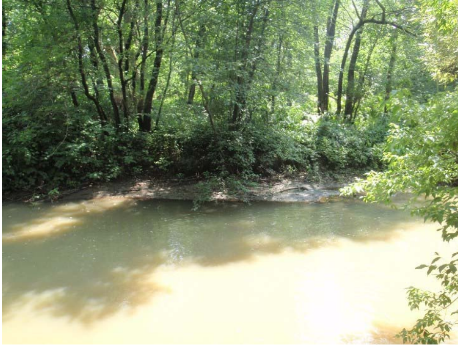
Photo 91 : Vue générale de la zone d'érosion ER-066 de la rivière Lorette.
