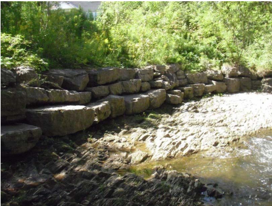
Photo 12 : Vue générale de l'enrochement #11 de la rivière Lorette.
