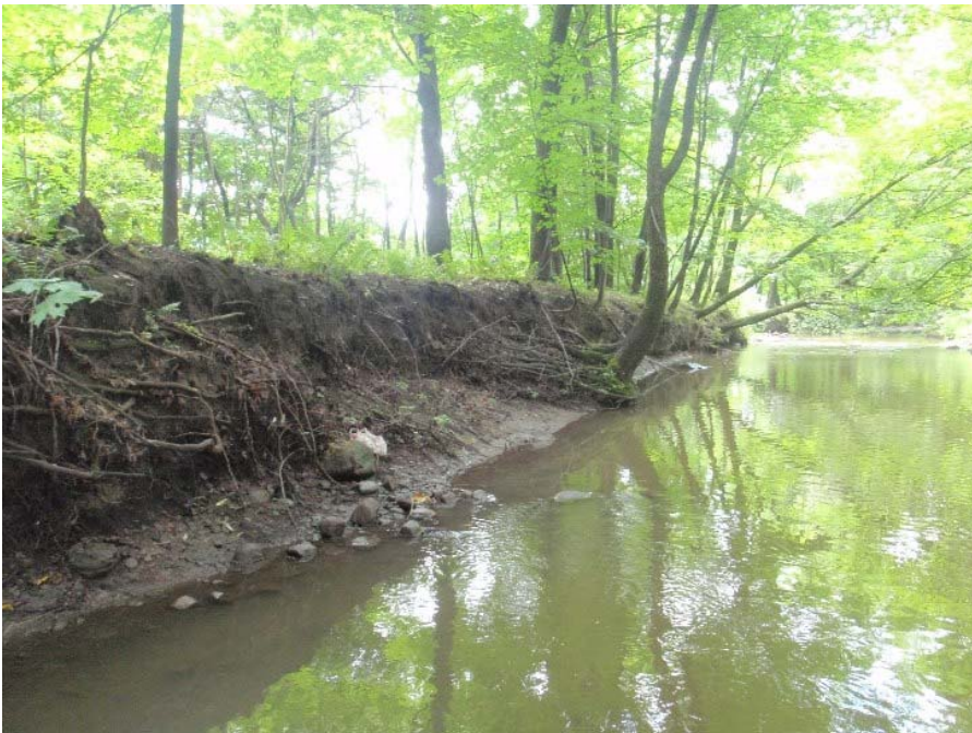
Photo 84 : Vue générale de la zone d'érosion ER-059 de la rivière Lorette.
