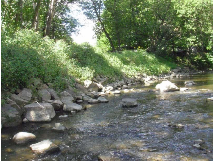
Photo 7 : Vue générale de l'enrochement #7 de la rivière Lorette.
