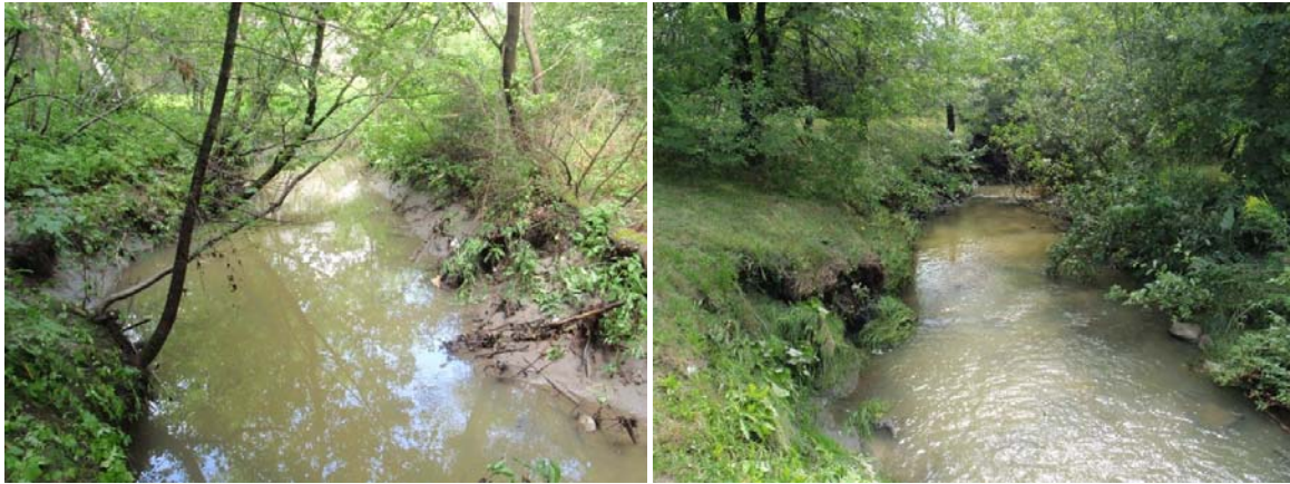
Photo 121 : Vue générale de la zone d'érosion ER-ND-30 du ruisseau Notre-Dame.
