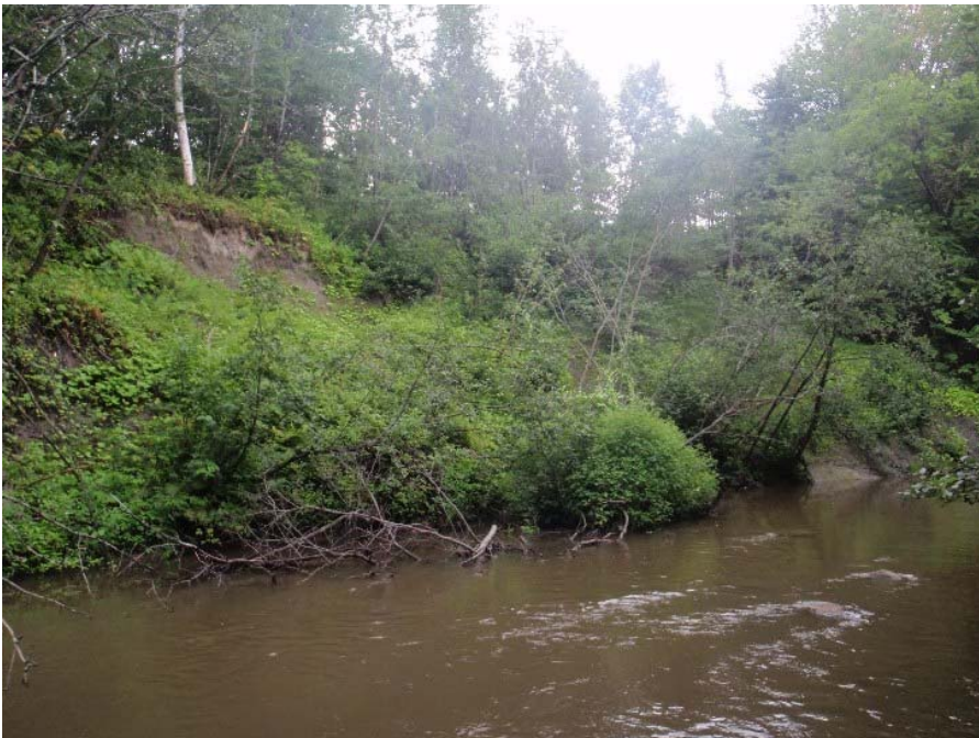
Photo 70 : Vue générale de la zone d'érosion ER-040 de la rivière Lorette.
