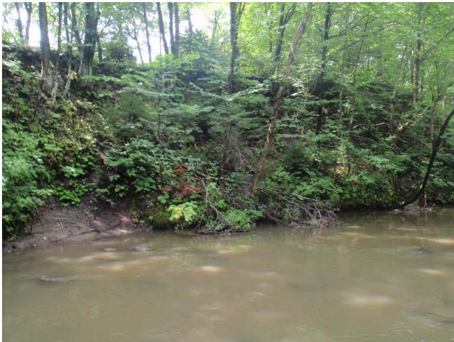
Photo 80 : Vue générale de la zone d'érosion ER-051 de la rivière Lorette.
