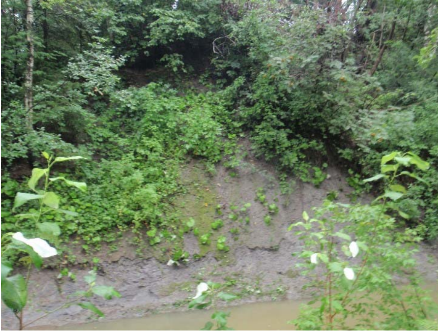
Photo 105 : Vue générale de la zone d'érosion ER-ND-10 du ruisseau Notre-Dame.
