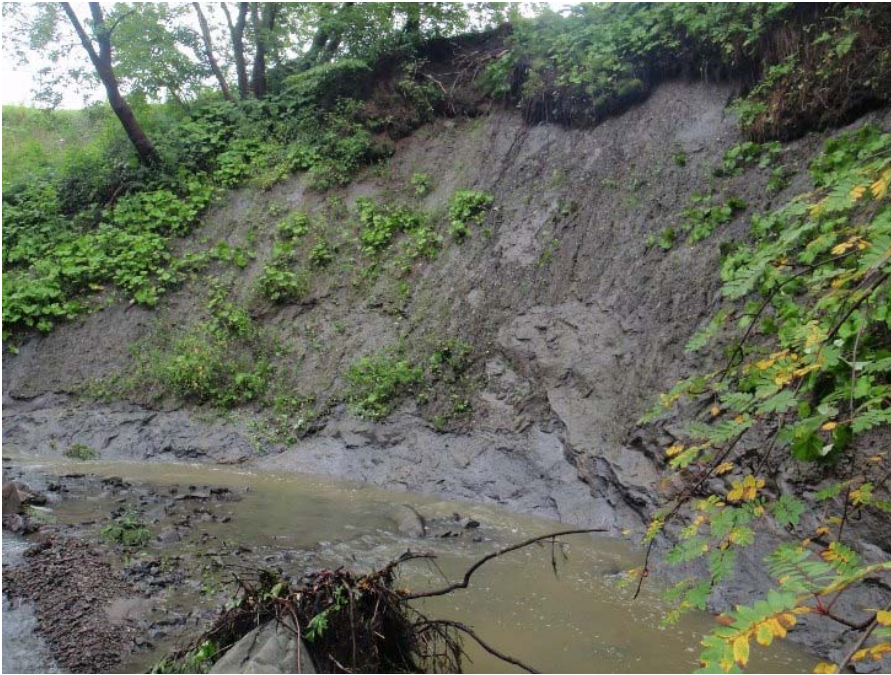
Photo 109 : Vue générale de la zone d'érosion ER-ND-17 du ruisseau Notre-Dame.
