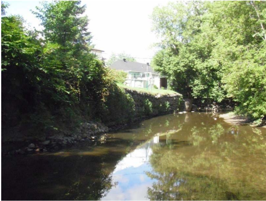
Photo 5 : Vue générale de l'enrochement #5 de la rivière Lorette.
