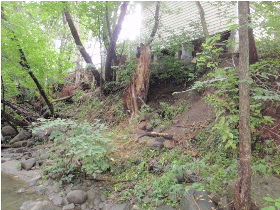
Photo 38 : Vue générale de la zone d'érosion ER-08 de la rivière Lorette.
