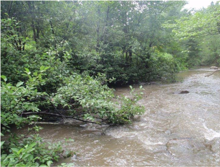
Photo 71 : Vue générale de la zone d'érosion ER-041 de la rivière Lorette.
