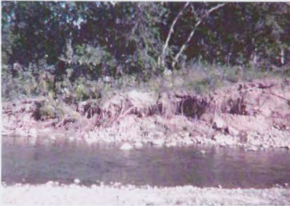
L'état naturel de la rive avant les travaux
