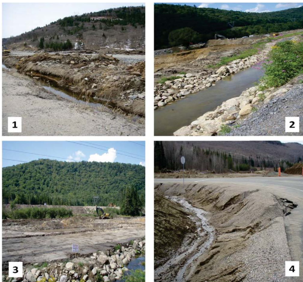
Photos 1 : Travaux au kilomètre 73 en mai 2011 (1); travaux au kilomètre 67 en août 2011 (2 et 3); érosion au chemin Whalen en mai 2011 (4).
