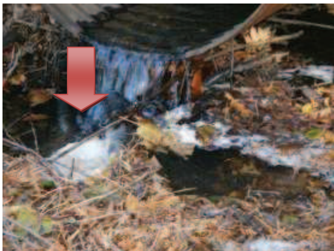
Photo 5 : Mousse observée à la conduite CPO11 B (octobre 2009)
