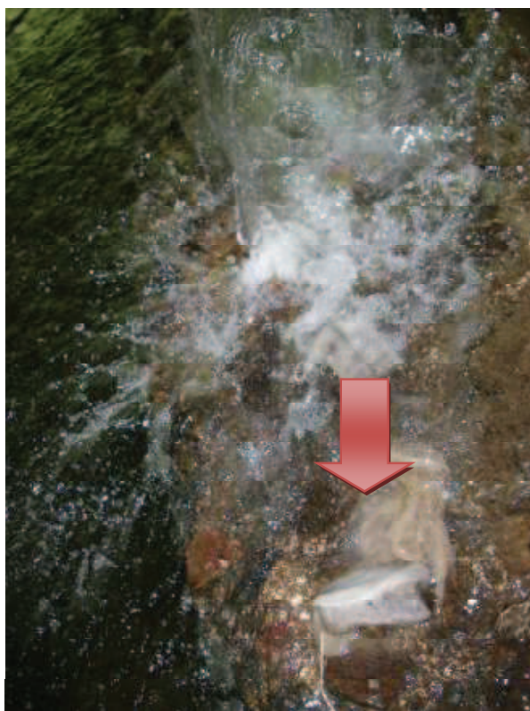
Photo 7 : Tampon hygiénique retrouvé à la conduite CPO20 (juillet 2009)
