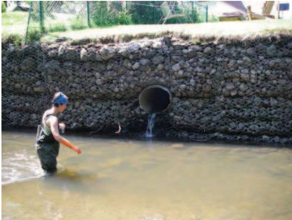
Photo 1 : Échantillonnage de la conduite CPLO211 en juillet 2009
