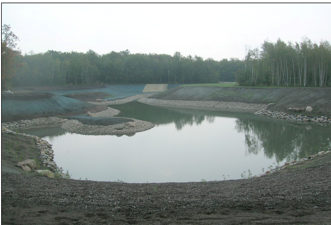
Figure 2-23 : Exemple d'une zone de rétention (17 000 m³)
