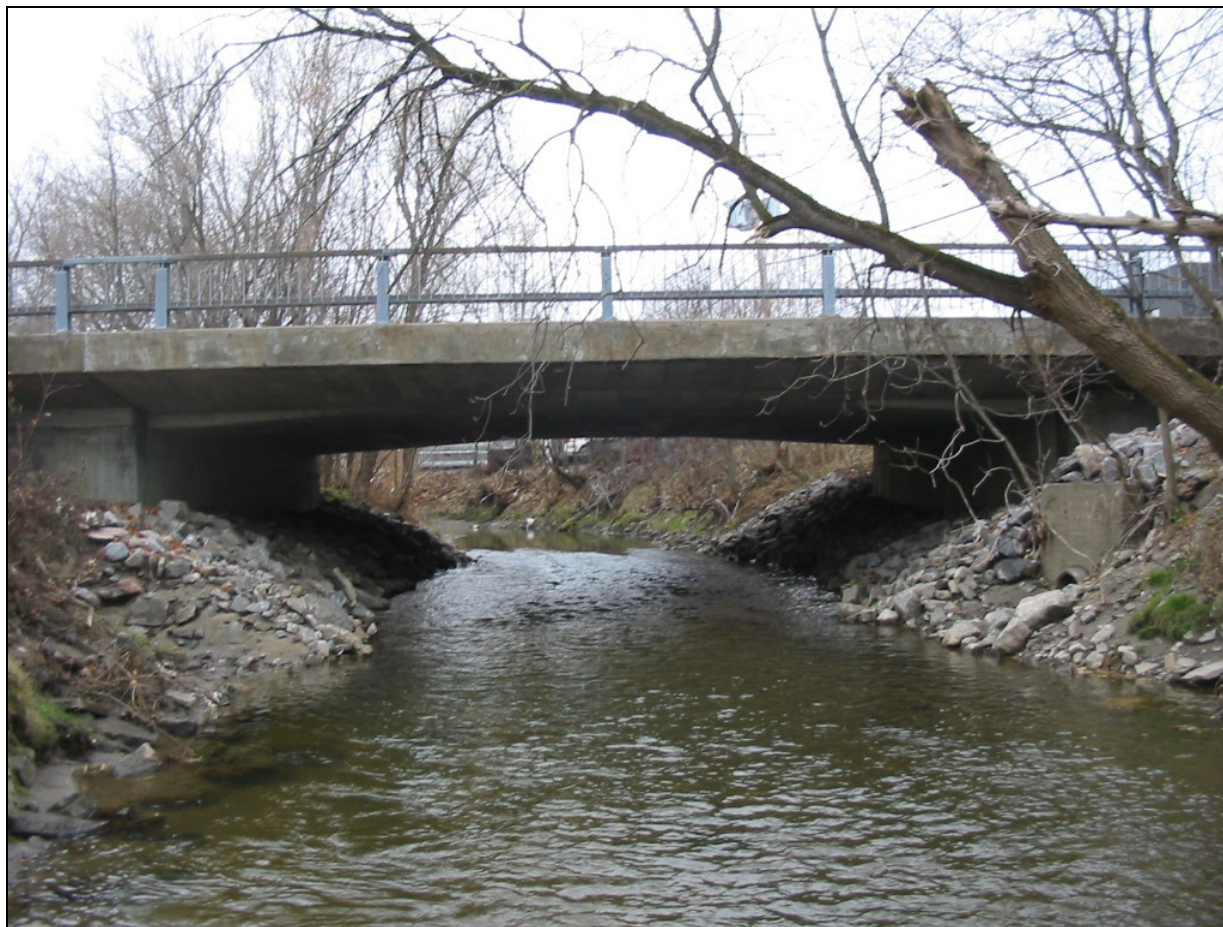
Figure 2-50 : Restriction hydraulique locale au site 6 : Ch. 2+800 - Pont rue Michel-Fragasso (13 novembre 2007)
