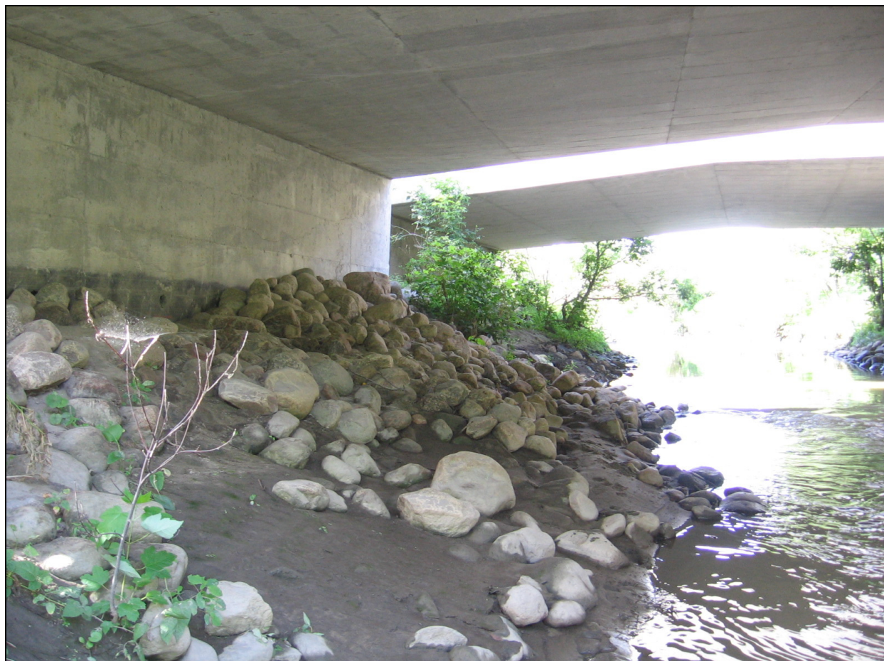
Figure 2-46 : Restriction hydraulique locale au site 2 : Ch. 1+430 - Pont des Ingénieurs (16 août 2006)
