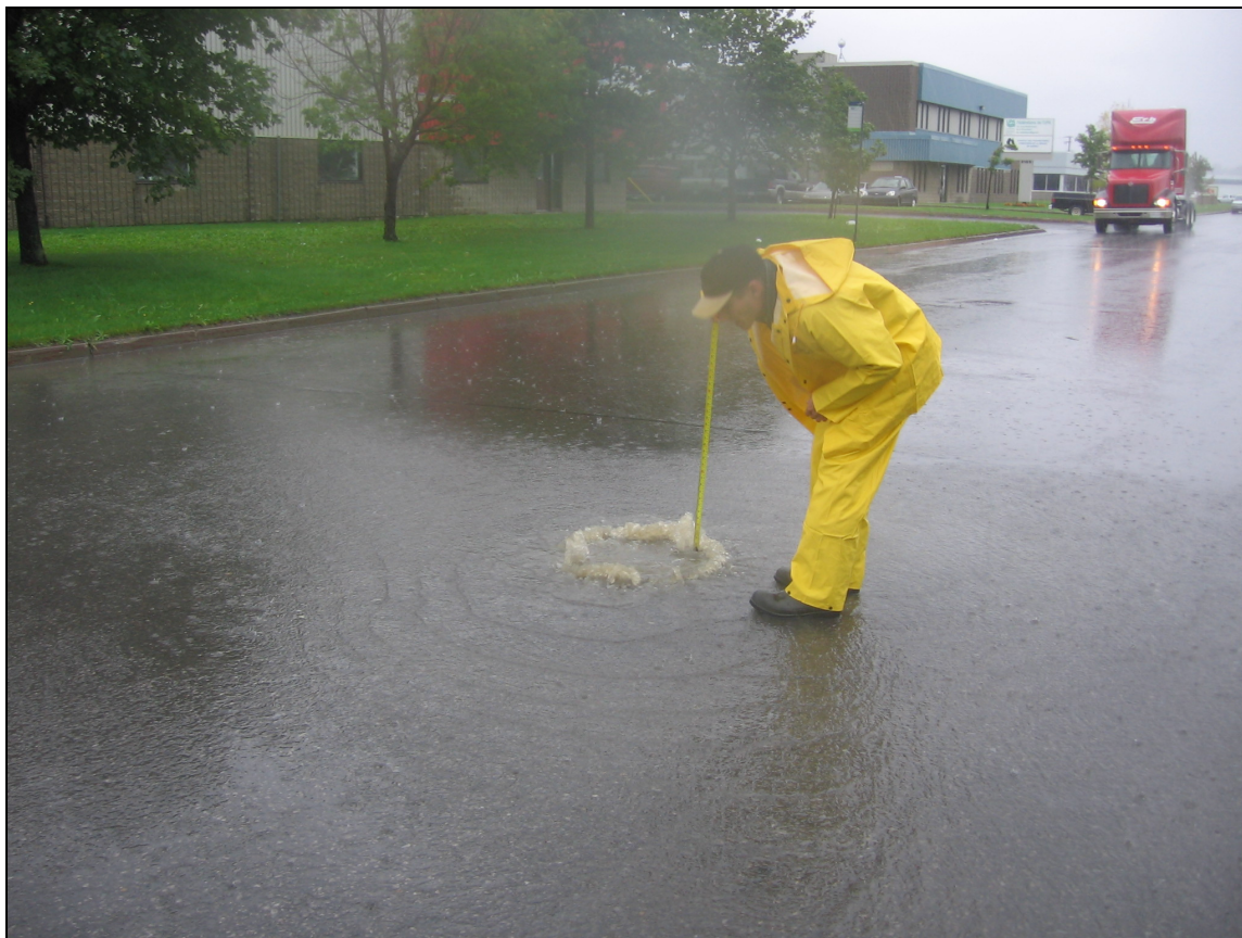
Figure 2-35 : Débordement du réseau d'égout pluvial sur la rue Rideau (photographie prise le 26 septembre 2005)
