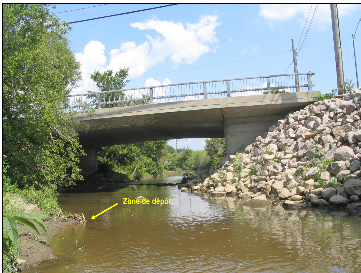
Figure 2-47 : Restriction hydraulique locale au Site 3 : Ch. 1+760 - Amont du pont Saint-Jean-Baptiste (4 août 2006)
