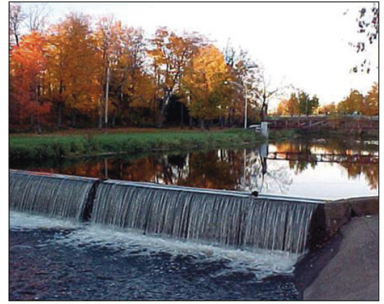
Photo 25: Ligne des hautes eaux, en présence d'un ouvrage de retenue, correspond à la cote maximale d'exploitation
