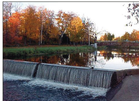
Photo 3 : En présence d'un ouvrage de retenue, la ligne des hautes eaux correspond à la cote maximale d'exploitation
