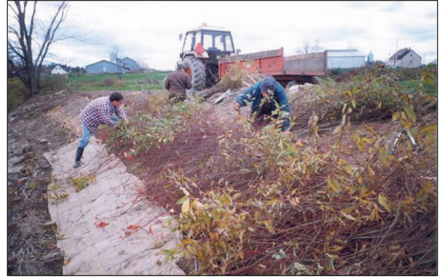
Photo 15 : Installation de matelas de branches
