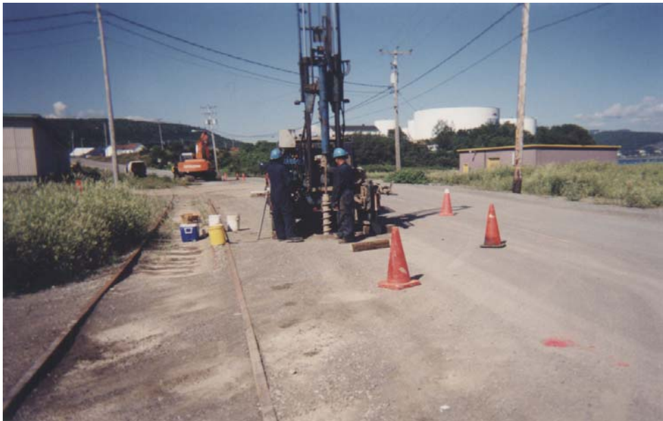
Photo 10 : Réalisation du forage PO03-65 (lot B5-2). Le périmètre de travail est délimité par des cônes de sécurité. On aperçoit en arrière plan les travaux d'excavation des tranchées d'exploration ainsi que des réservoirs pétroliers des compagnies Irving et Ultramar. (01-07-03)
