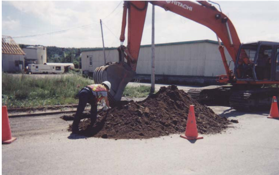
Photo 5 : Réalisation de la tranchée d'exploration TP-77 (lot B5-2). Le remblai qui atteint une profondeur de 2,8 m est constitué de sable avec des lentilles de silt gris, de gravier et de traces de scories. Échantillonnage composite du remblai à tous les mètres de profondeur. Le périmètre de travail est délimité par des cônes et des barrières de sécurité. (01-08-03)
