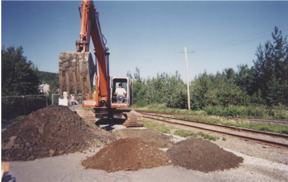
Photo 3 : Réalisation de la tranchée d'exploration TP-60 (lot 50). Les sols provenant de l'excavation sont ségrégués en fonction de la lithologie et déposés en piles distinctes pour l'échantillonnage. (31-07-03)
