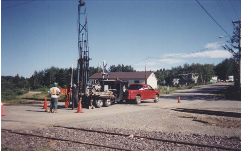
Photo 9 : Réalisation de forage du PO03-63 (lot 50). Un signaleur de la compagnie « Chemin de fer de la Matapédia et du Golf » est présent lors des travaux effectués près de la voie ferrée. (31-07-03)
