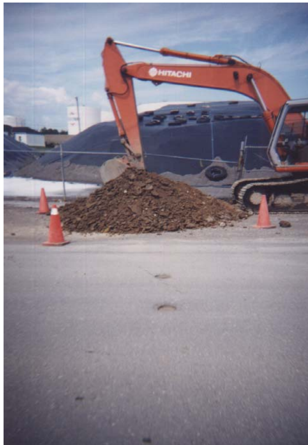
Photo 5 : Réalisation de la tranchée d'exploration TP-77 (lot B5-2). Le remblai qui atteint une profondeur de 2,8 m est constitué de sable avec des lentilles de silt gris, de gravier et de traces de scories. Échantillonnage composite du remblai à tous les mètres de profondeur. Le périmètre de travail est délimité par des cônes et des barrières de sécurité. (01-08-03)
