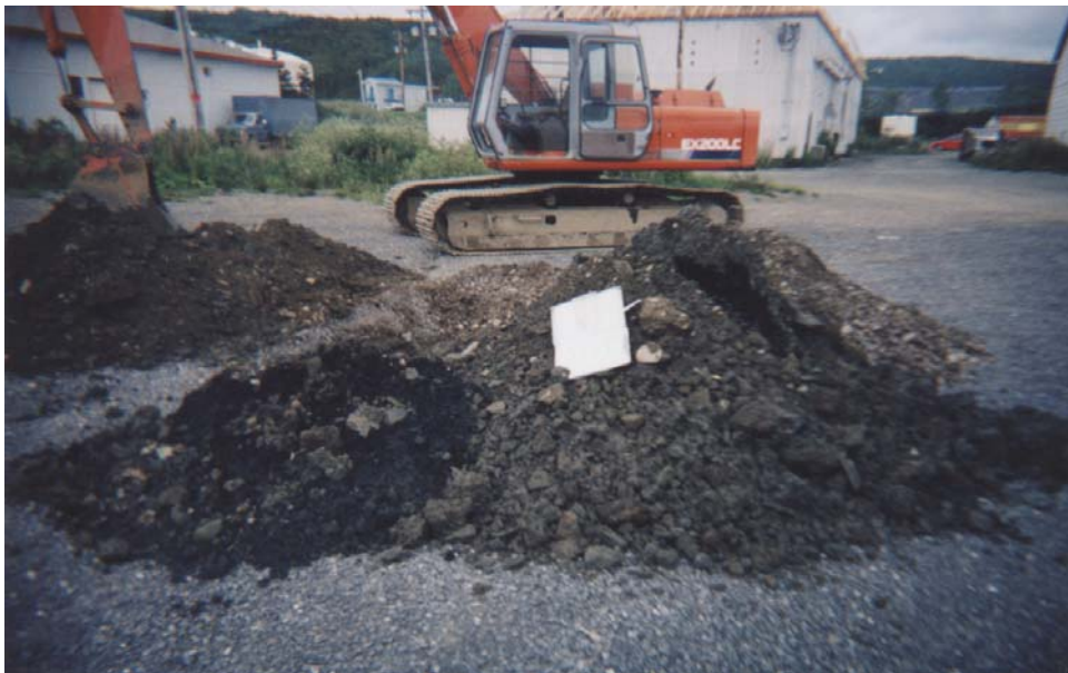
Photo 8 : Réalisation de la tranchée d'exploration TP-103 (lot 1-4). On aperçoit les piles de remblais ainsi que les sols organiques noirs qui sont précédés de silt gris verdâtre. (06-08-03)
