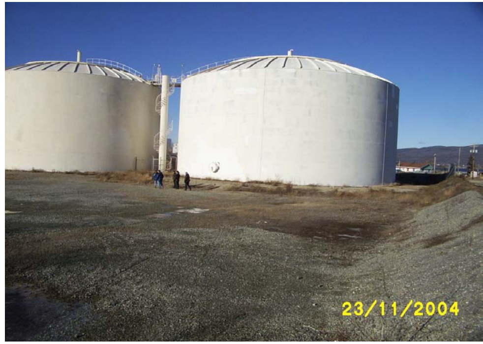
Photo n° 5. Vue vers le nord-ouest des deux réservoirs de stockage d'acide sulfurique désaffectés de Noranda..
