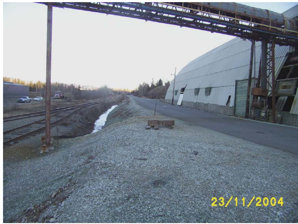
Photo n° 6. Vue vers l'est de l'entrepôt de concentré de cuivre désaffecté de Noranda, ainsi que du chemin de fer et de la route d'accès adjacents.
