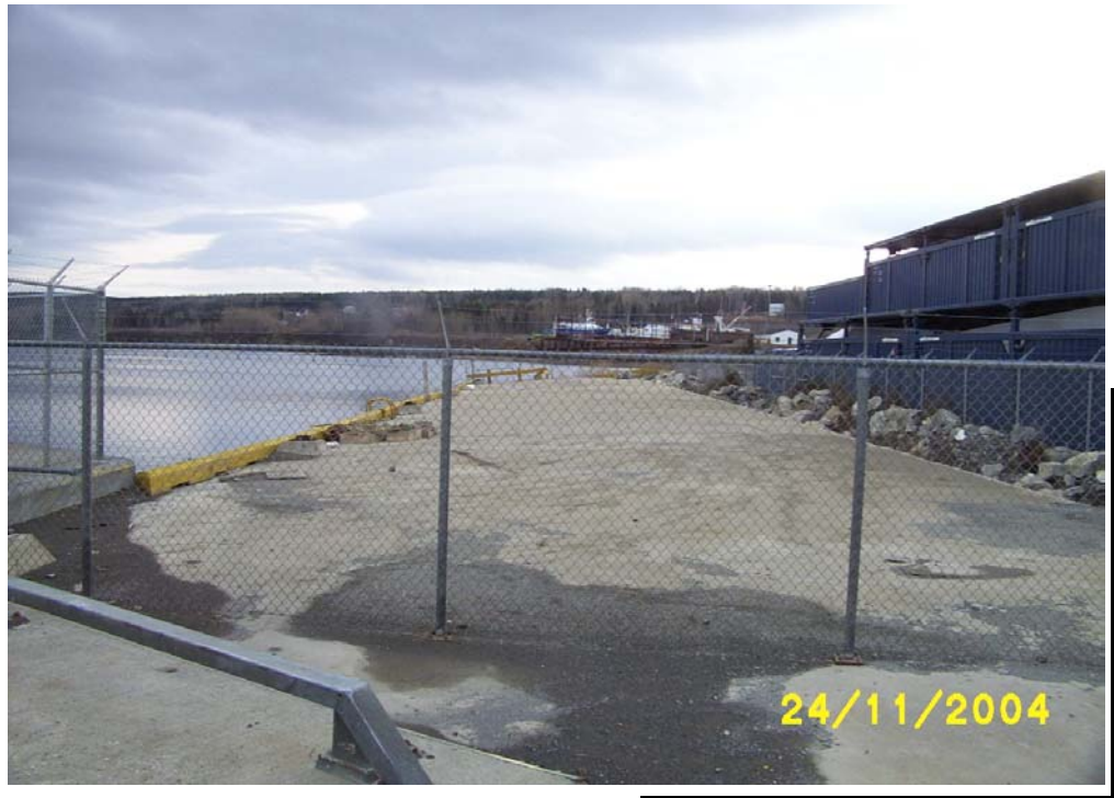
Photo n° 3. Vue vers le sud-est du quai des pêcheurs.
