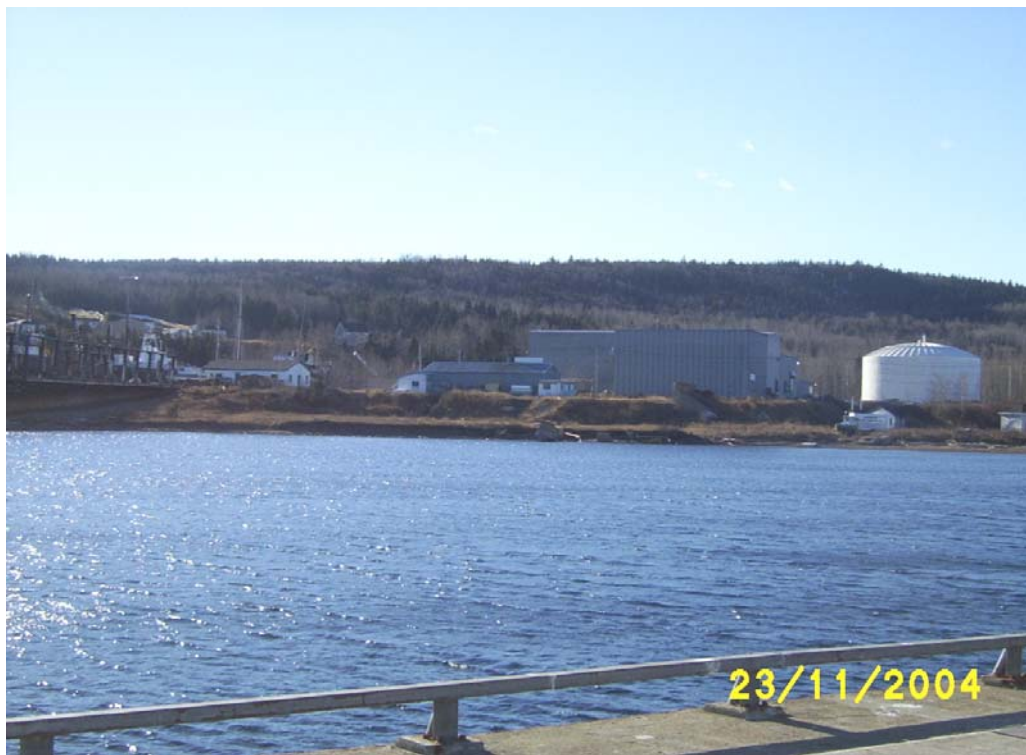
Photo n° 2. Vue vers le sud de la rive située entre la cale de halage du chantier maritime et le quai des pêcheurs (hors photo, à droite). On y constate les bâtiments du chantier maritime en arrière plan, l'un des deux réservoirs d'acide désaffectés de Noranda, la cale de halage à gauche, ainsi que le vivier de homards au centre (bâtiment gris et bleu).
