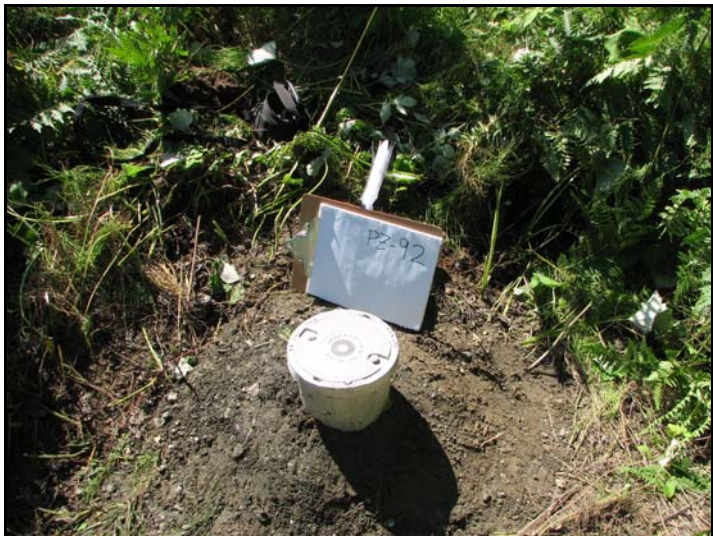
Photo 13 : PZ-92 aménagé avec une boîte de protection et monticule de terre.
