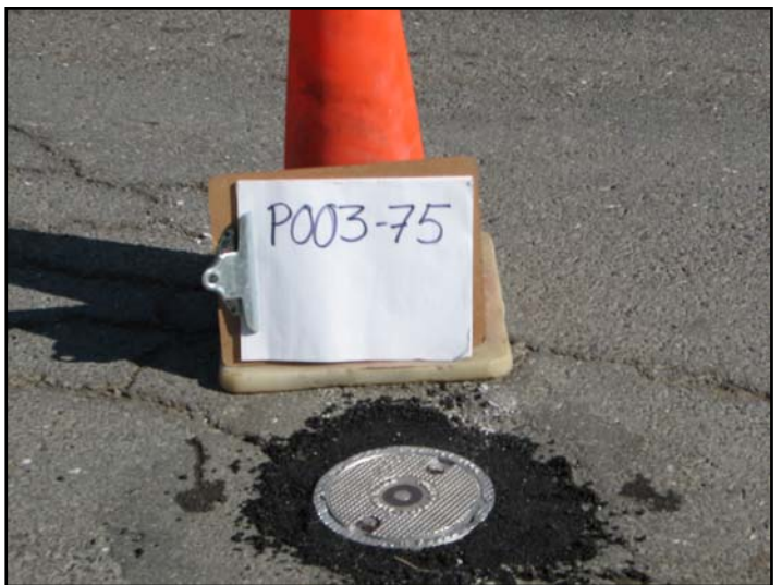
Photo 17 : Travaux de réparation terminés.
