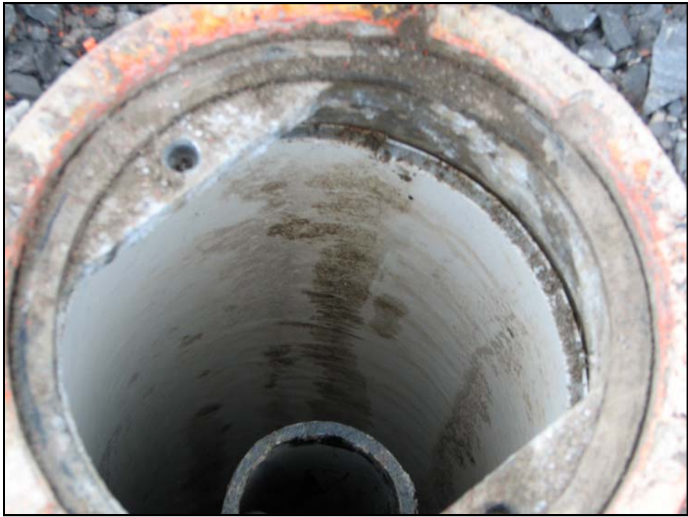
Photo 8 : Vue intérieure du puits PZ-111 ayant été rehaussé par DJL.
