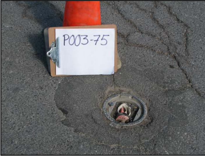
Photos 14 et 15 : État du puits d'observation PO03-75 avant les travaux de réparation (sans couvercle protecteur, les boulons coincés, bouchon cassé, tête de puits remplie de terre).
