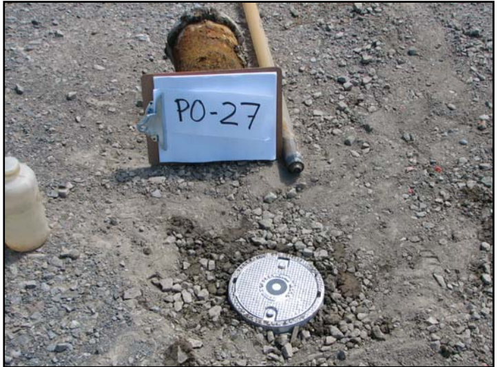
Photo 19 : État du puits PO-27 après les travaux.
