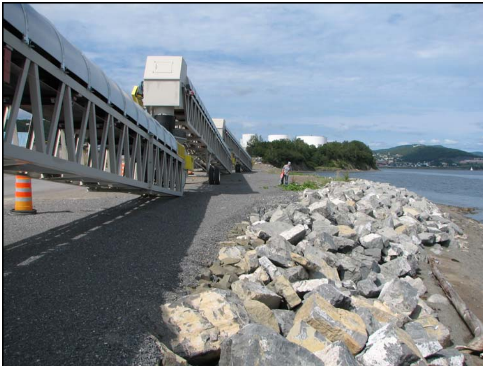
Photo 4 : Extrémité nord du site portuaire, vue en direction de l'ouest. On remarque le remblai de gravier rehaussant l'ancien terrain, et l'aménagement d'un brise-lames en bordure de la mer.
