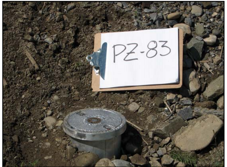
Photo 21 : État du puits PZ-83 après les travaux.
