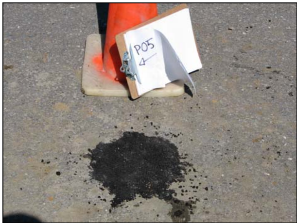
Photo 32 : Scellement du trou laissé par l'ancien emplacement de PO-5.
