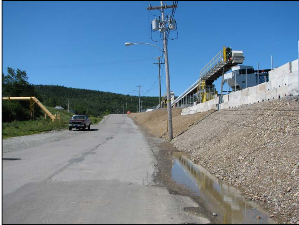
Photo 5 : Rue du quai, vue en direction du sud-ouest. On remarque les installations de DJL du côté droit de la rue.
