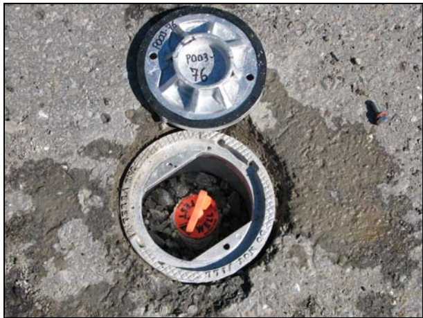
Photo 30 : Boîte de protection mise en place remplie de gravier propre.
