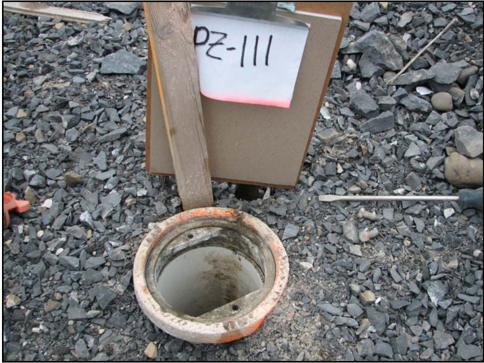
Photo 7 : Tête de puits et tubage ayant été rehaussés par DJL.
