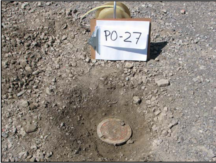
Photo 18 : État du puits PO-27 avant les travaux.
