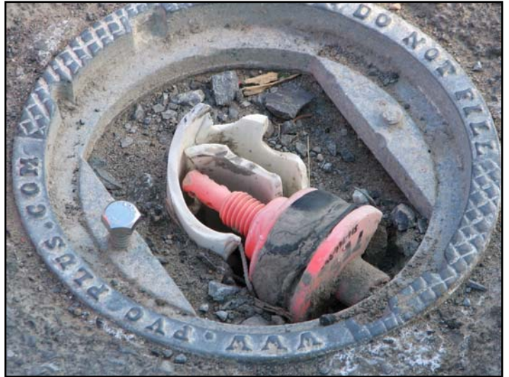
Photos 14 et 15 : État du puits d'observation PO03-75 avant les travaux de réparation (sans couvercle protecteur, les boulons coincés, bouchon cassé, tête de puits remplie de terre).
