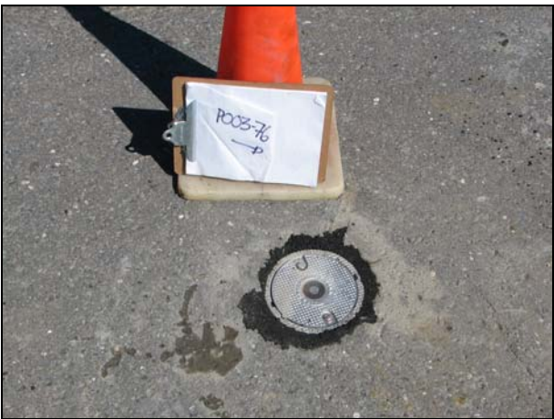
Photo 31 : Boîte de protection scellée avec de l'asphalte froide.
