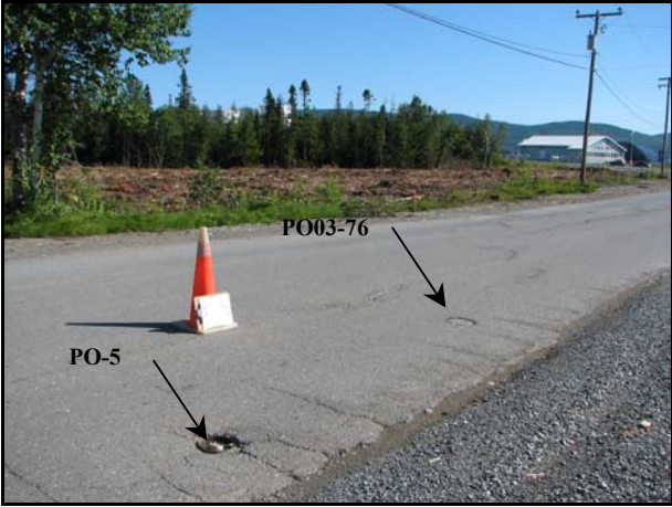
Photos 27 à 30 : Étapes de réparation du puits PO03-76.
