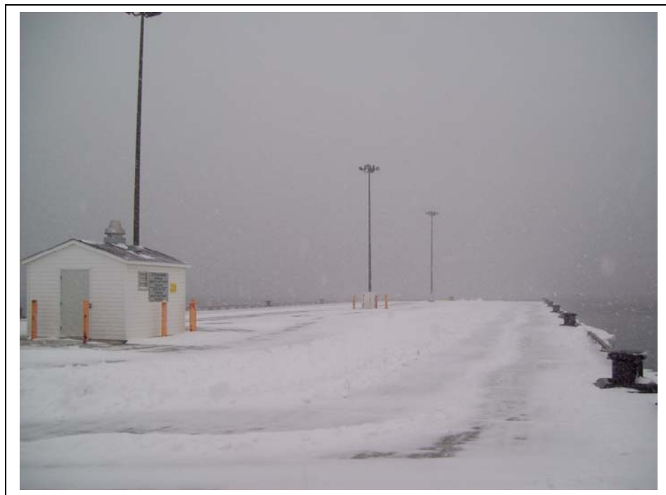
Photo 4 : Vue d'une portion du quai; vue direction est.
