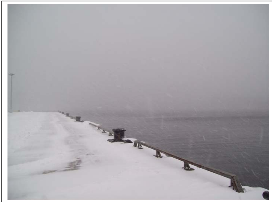
Photo 1 : Vue d'une portion du quai et de la baie de Gaspé; vue direction est.
