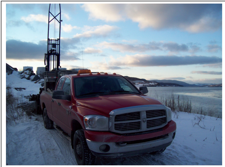
Photo 2 : Vue de l'emplacement du forage F-4, sur le lot 1-1-1; vue direction nord-ouest.
