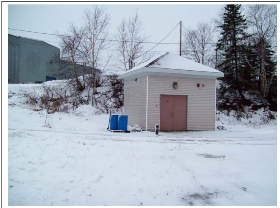
Photo 1 : Vue du puits d'observation PO-2; vue direction ouest.
