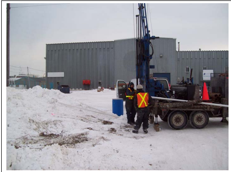
Photo 3 : Vue de la réalisation du puits d'observation PO-3; vue direction sud-est.
