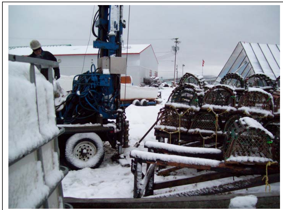
Photo 6 : Vue de la réalisation du puits d'observation PO-5; vue direction nord-est.
