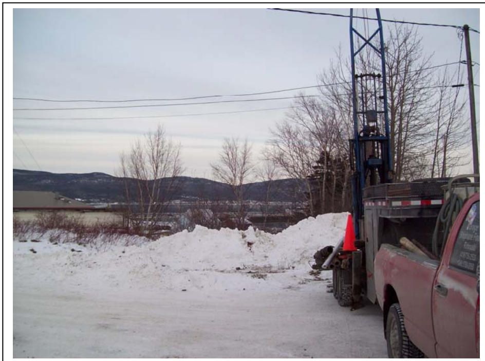
Photo 2 : Vue de la réalisation du puits d'observation PO-3; vue direction nord-est.
