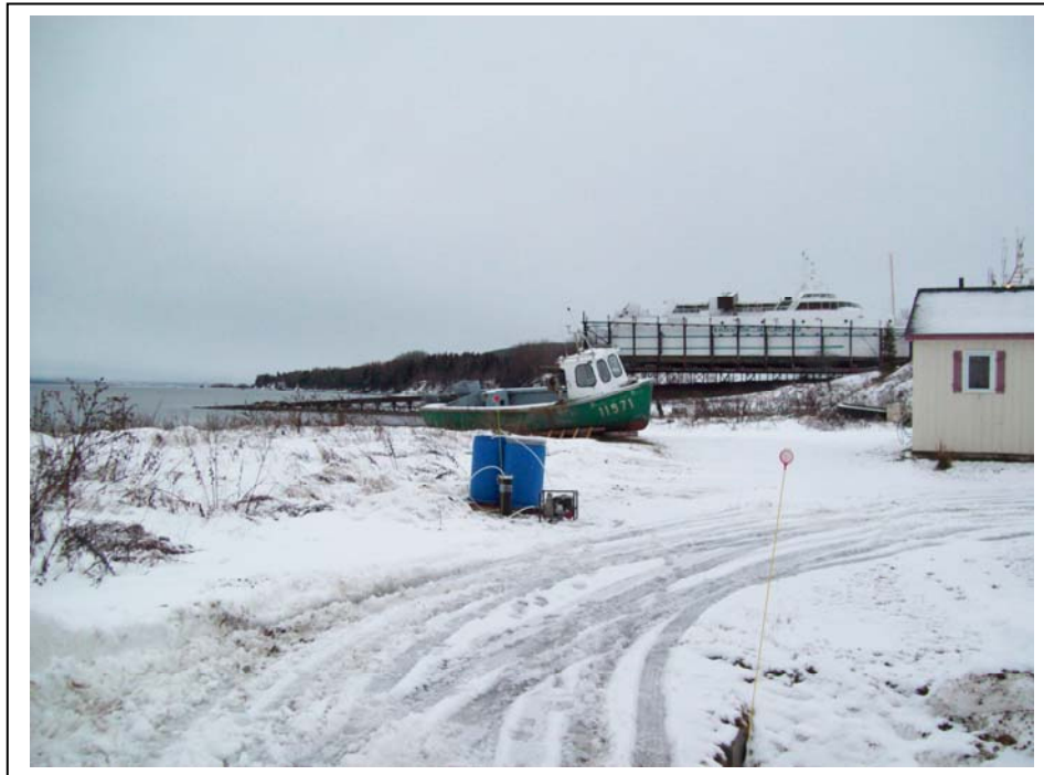
Photo 5 : Vue de la réalisation du puits d'observation PO-4; vue direction sud-est.
