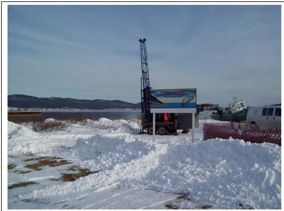
Photo 4 : Vue de la réalisation du puits d'observation PO-4; vue direction est.
