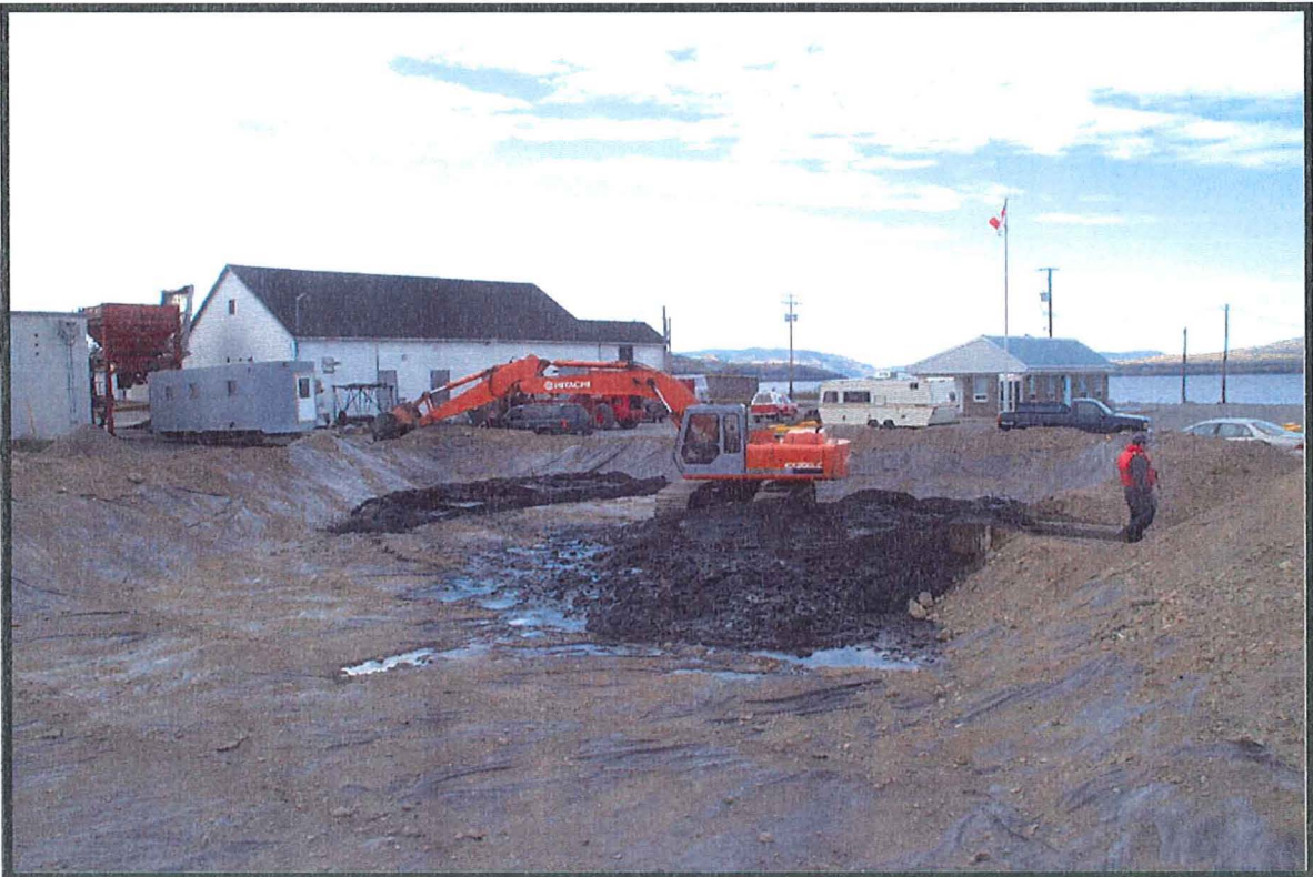
Disposition des sédiments excavés sur la zone d'entreposage temporaire
