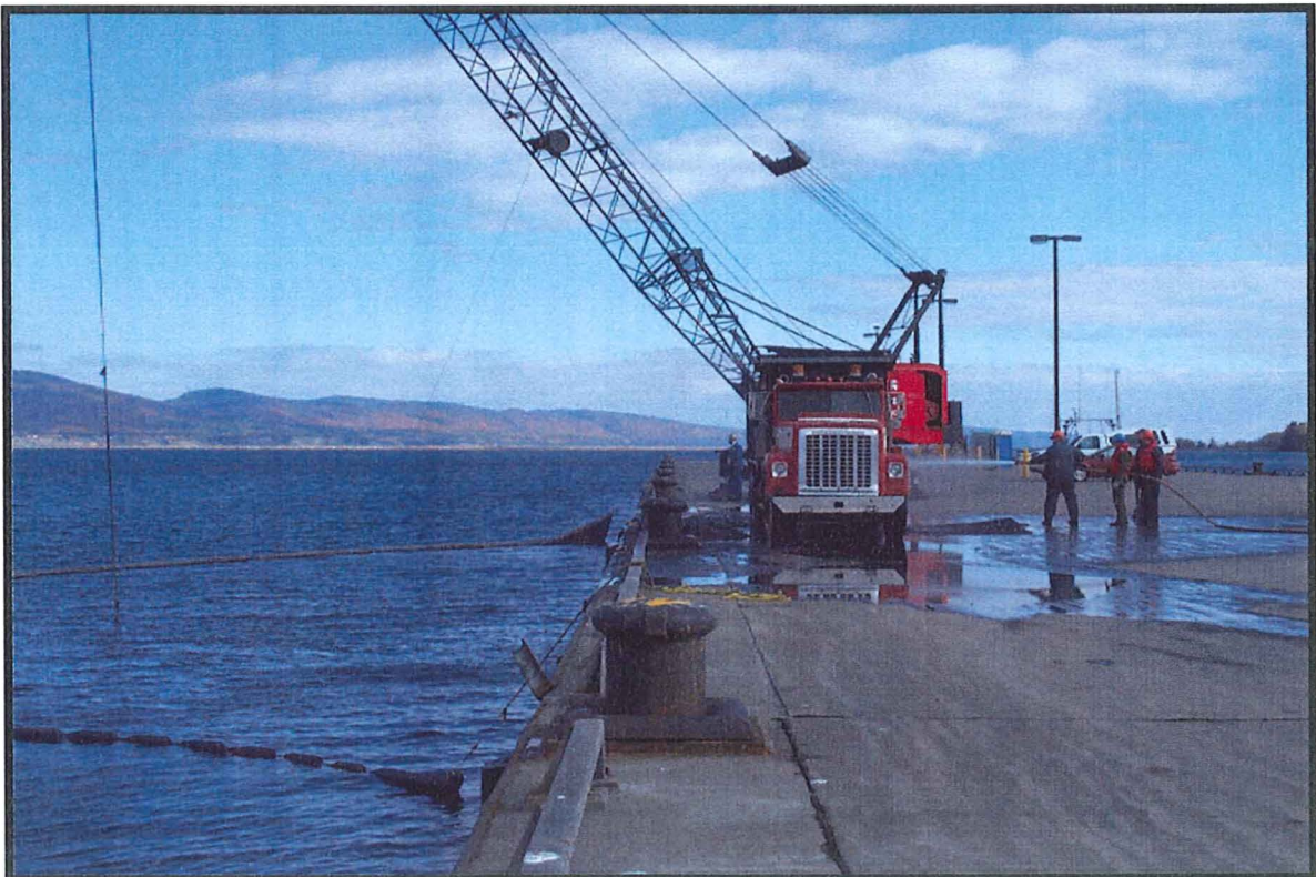
Nettoyage du camion avant le transport et écoulement des eaux dans l'enceinte des travaux
