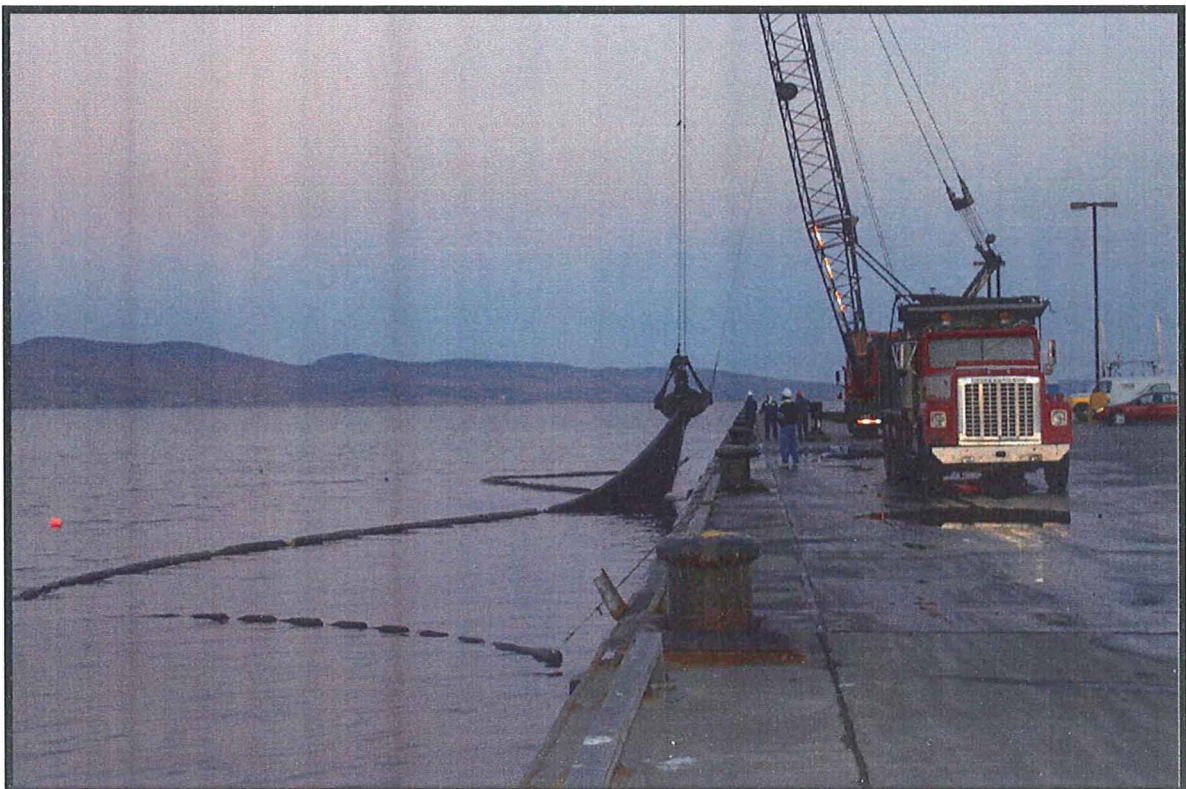
Accrochage accidentel du rideau de géotextile lors de l'excavation
