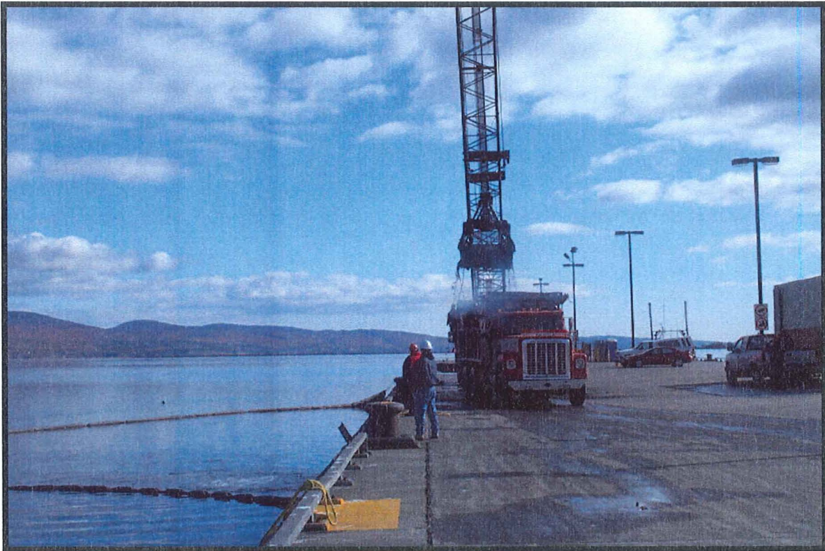
Excavation, égouttement sommaire et chargement du camion
