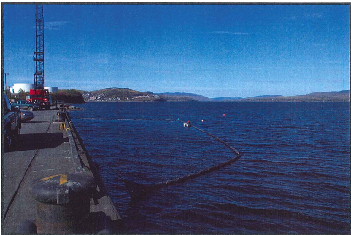
Mise en place du rideau de géotextile
