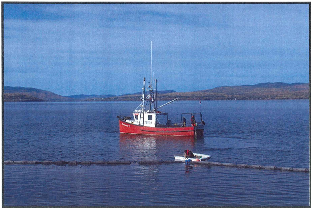
Mise en place du rideau de géotextile
