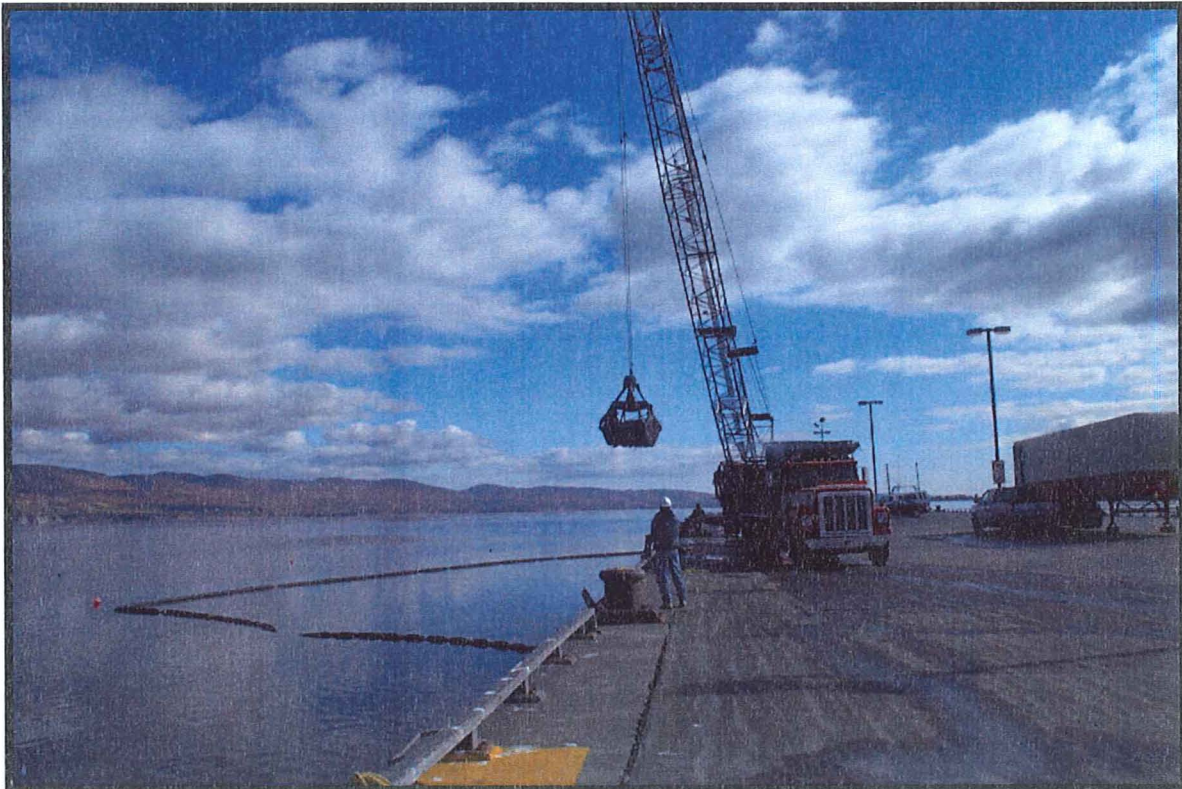
Excavation, égouttement sommaire et chargement du camion
