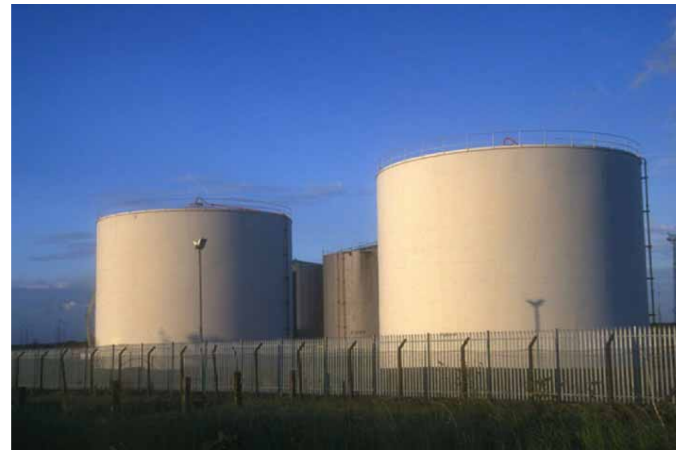
Réservoir à toit fixe (distillat)
