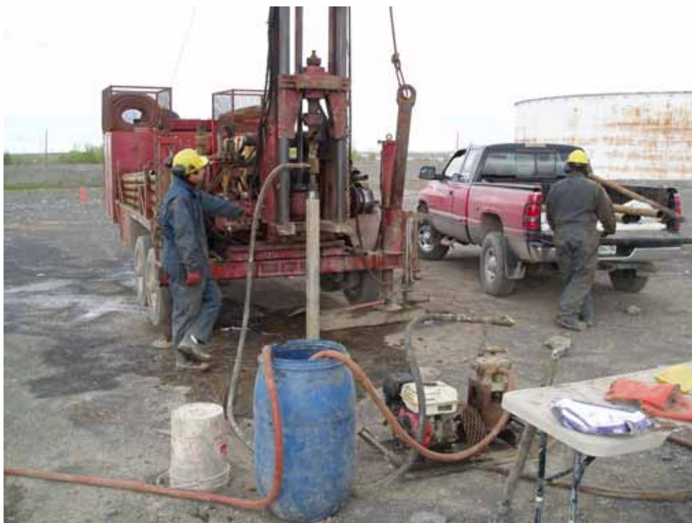
Photo 1 : Travaux de forage du puits PO-05-1.
