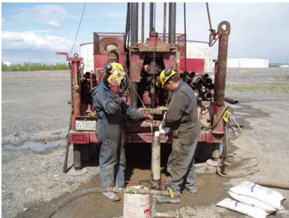
Photo 2 : Travaux d'installation du puits PO-05-1.
