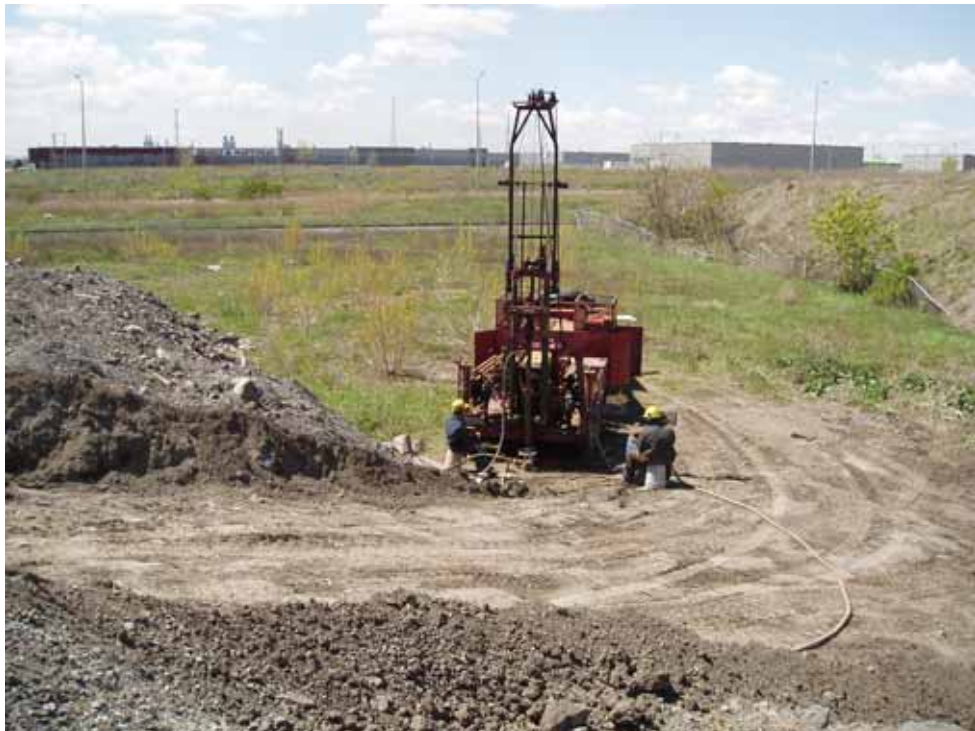
Photo 4 : Travaux de forage du puits PO-05-3 dans le coin nord-ouest à la base de la butte.
