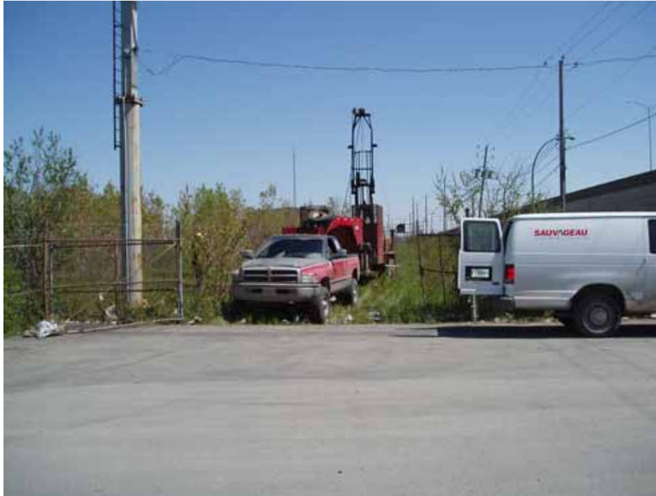
Photo 2 : Travaux de forage du puits PO-05-5.
