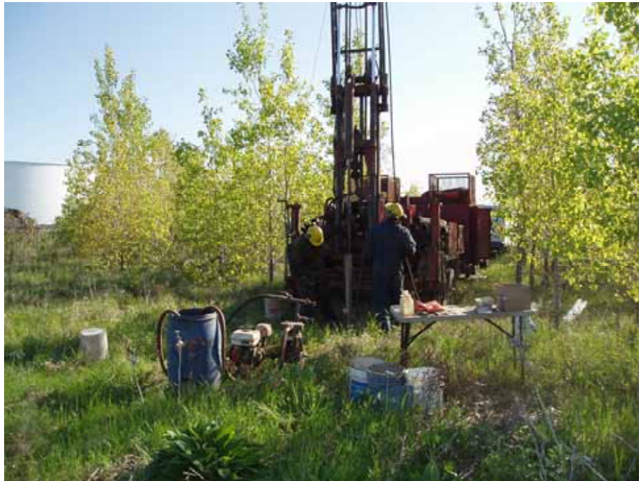
Photo 1 : Travaux de forage du puits PO-05-4.
