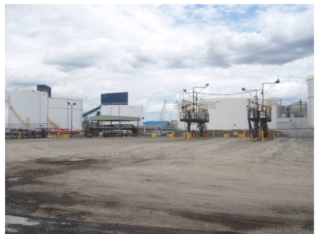
Figure 8 : Aire de circulation des camions
