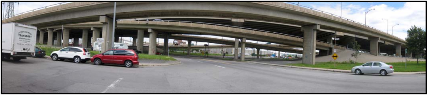
Repère A Première résidence au Sud-Ouest (coin 1ère Rue et 9e Avenue)
