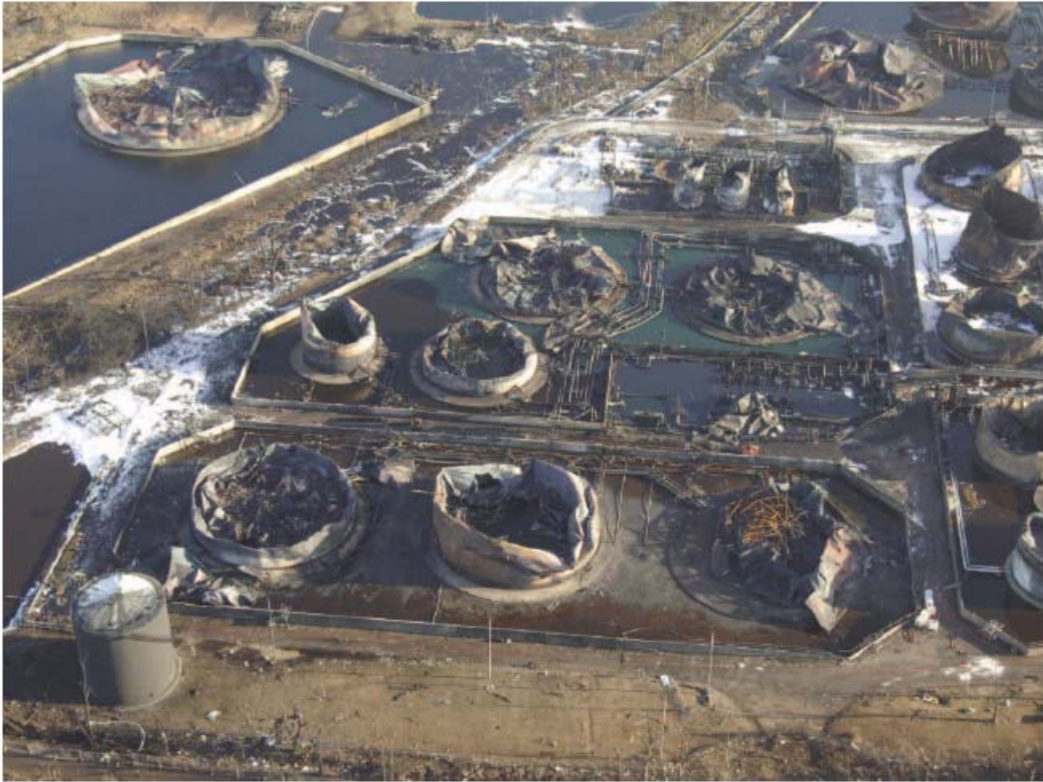
FIGURE 2 VUE DU DÉPÔT PÉTROLIER DE BUNCEFIELD APRÈS L'INCENDIE
